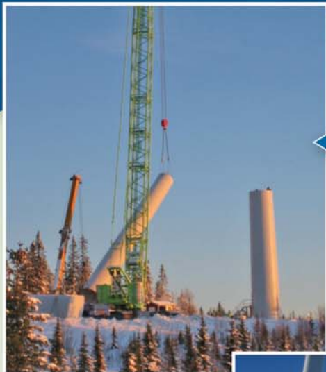
Assemblage de la tour
