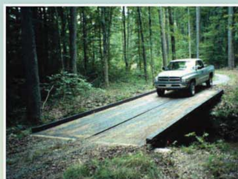
Pontage temporaire pour la traversée d'un cours d'eau par la machinerie
