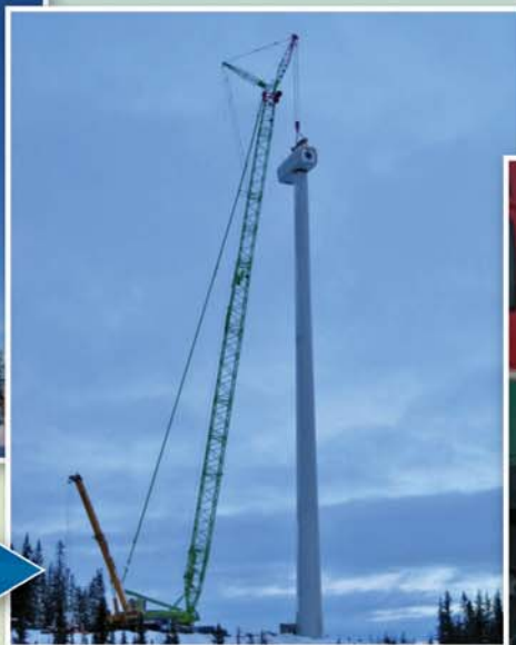
Mise en place de la nacelle
