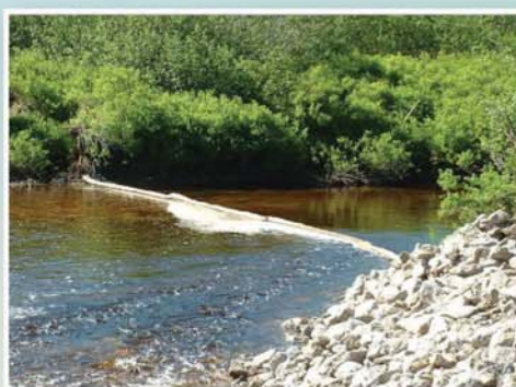
Mise en place d'une estacade flottante en aval des travaux
