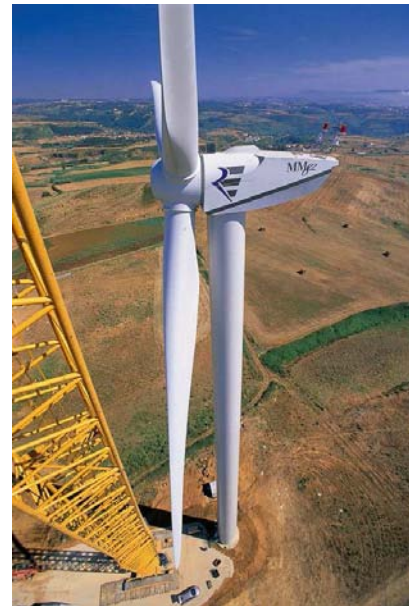
Figure 3.4 Assemblage de la tour
