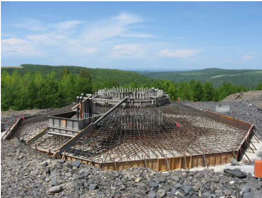
Figure 3.2 Exemple d'une fondation de masse
