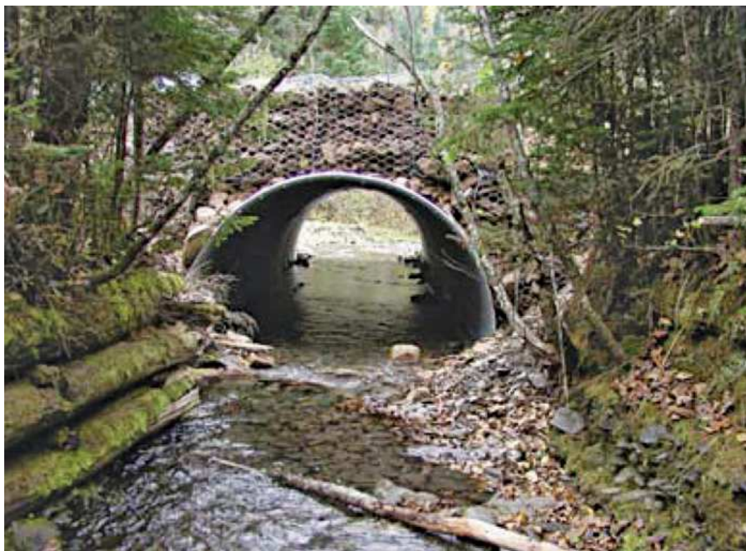
Figure 3.8 Exemple de ponceau en arche
