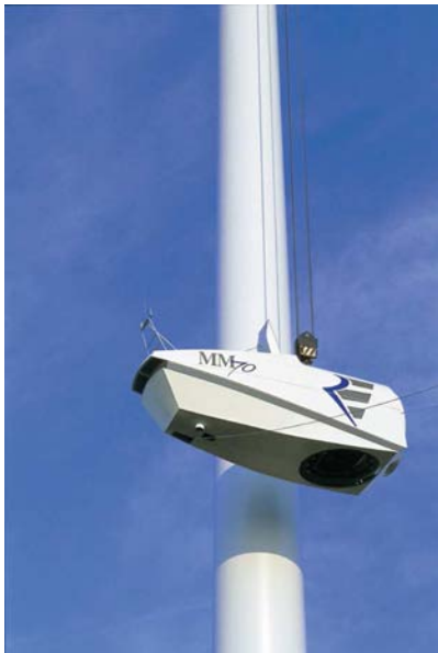
Figure 3.3 Montage de la nacelle
