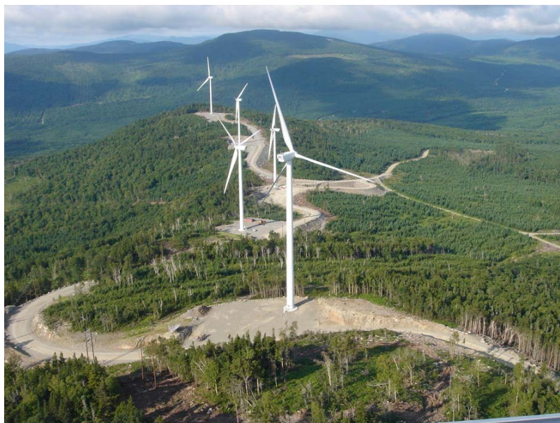
Photo 1 : aspect des éoliennes et des voies d'accès, parc éolien Kibby, Maine.
