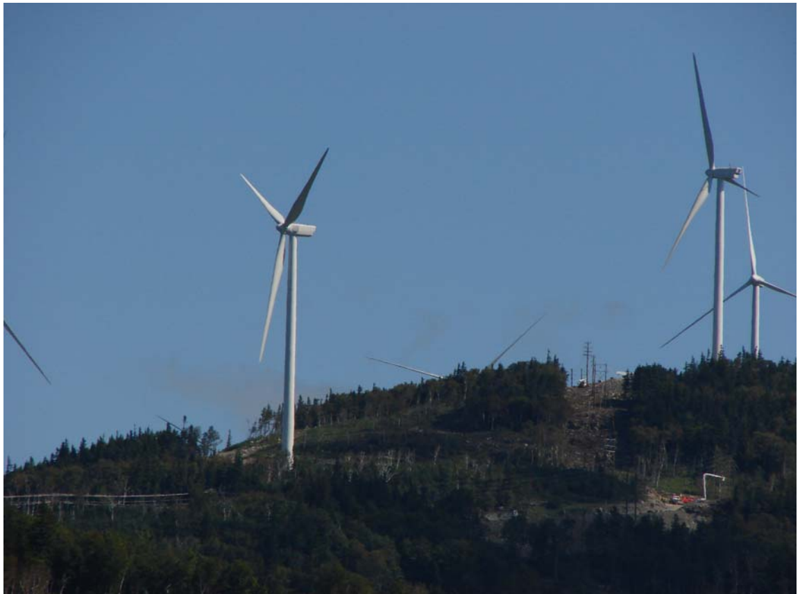
Photo 3 : Construction du parc éolien Kibby, Maine.
