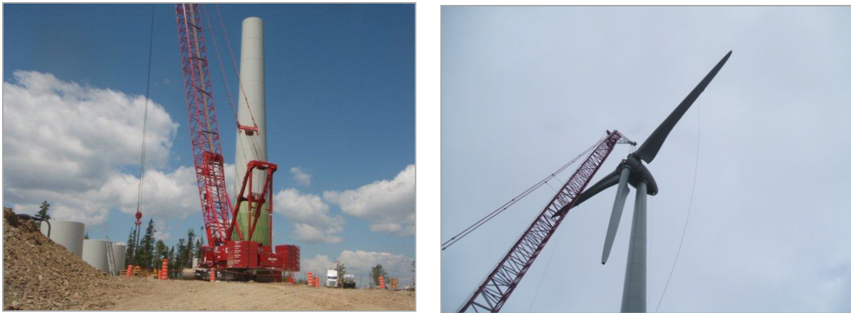
Figure 3.5 Assemblage d'une éolienne
