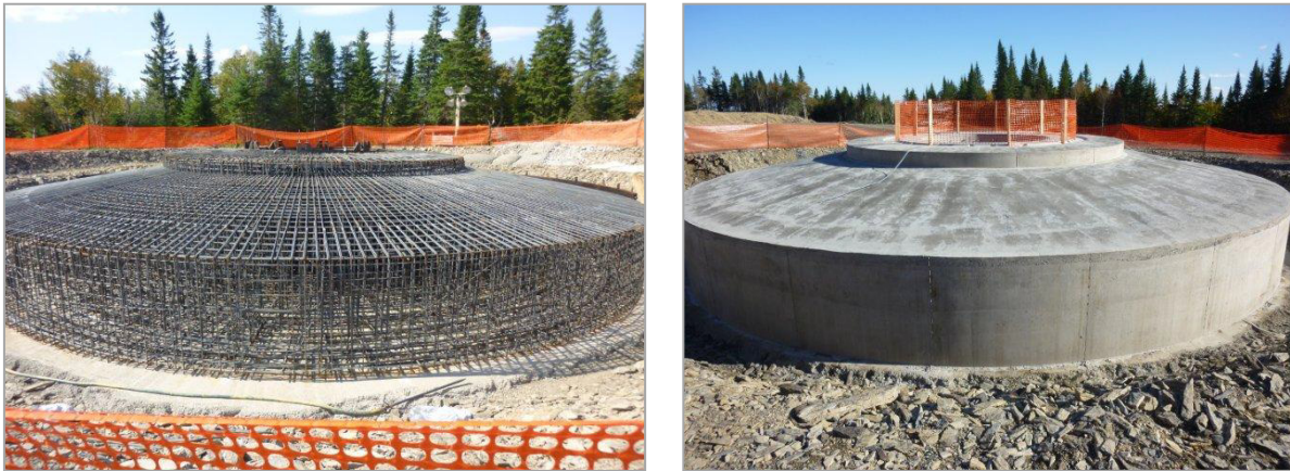
Figure 3.3 Fondation d'éolienne en construction
