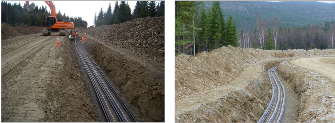
Figure 3.7 Installation des lignes électriques souterraines
