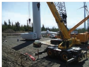
Mise en place de la nacelle La nacelle pèse 72 tonnes.
