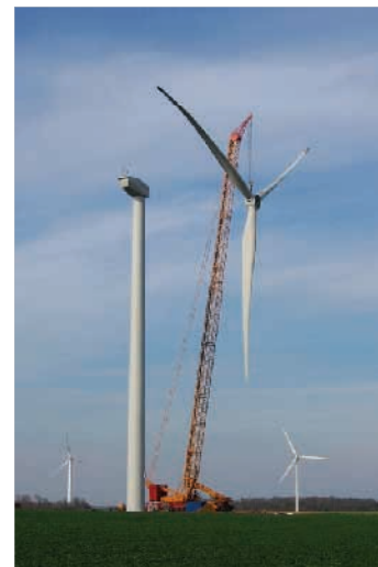
Installation du rotor
