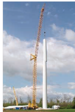
Assemblage de la tour
