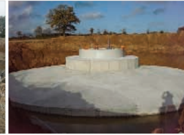
Coulage du béton Environ 350 m 3 de béton par fondation
