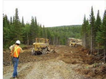
Construction des chemins
