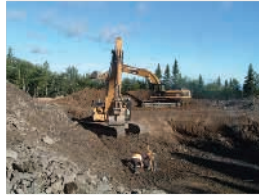
Excavation de la fondation Diamètre de la fondation de surface : environ 16,3 m
