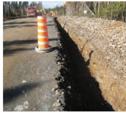
Enfouissement du réseau collecteur
