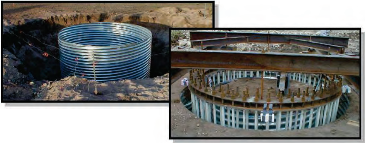
Figure 3.7 Fondation profonde annulaire
