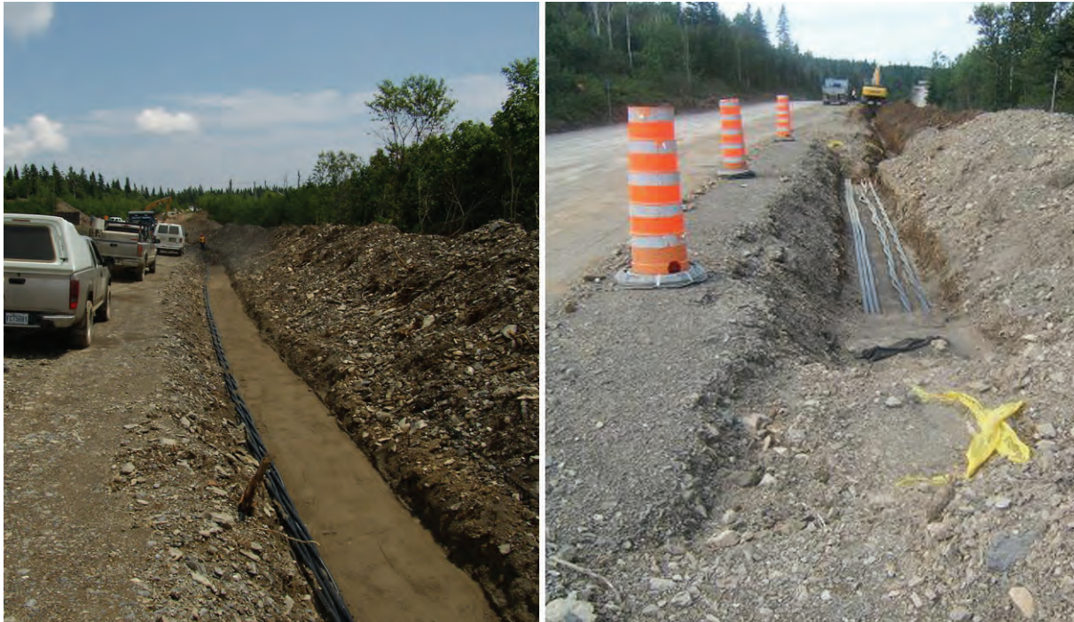
Figure 3.11 Installation des lignes électriques souterraines
