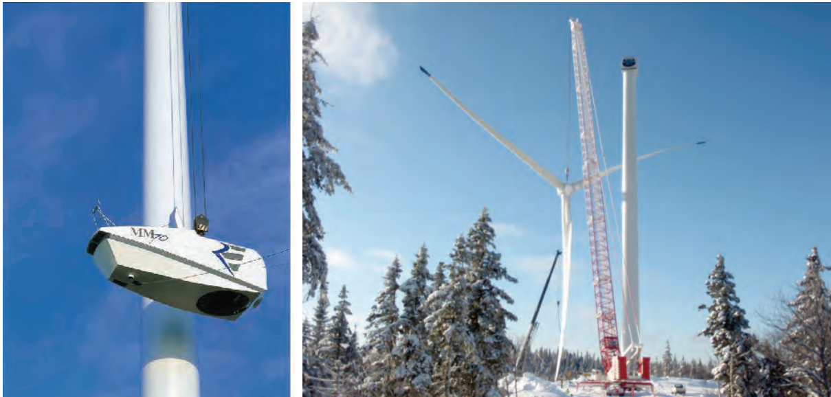
Figure 3.10 Assemblage d'une éolienne
