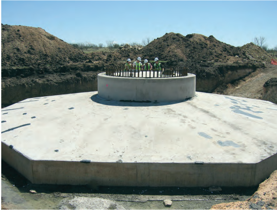
Figure 3.6 Fondation de masse (ou superficielle)
