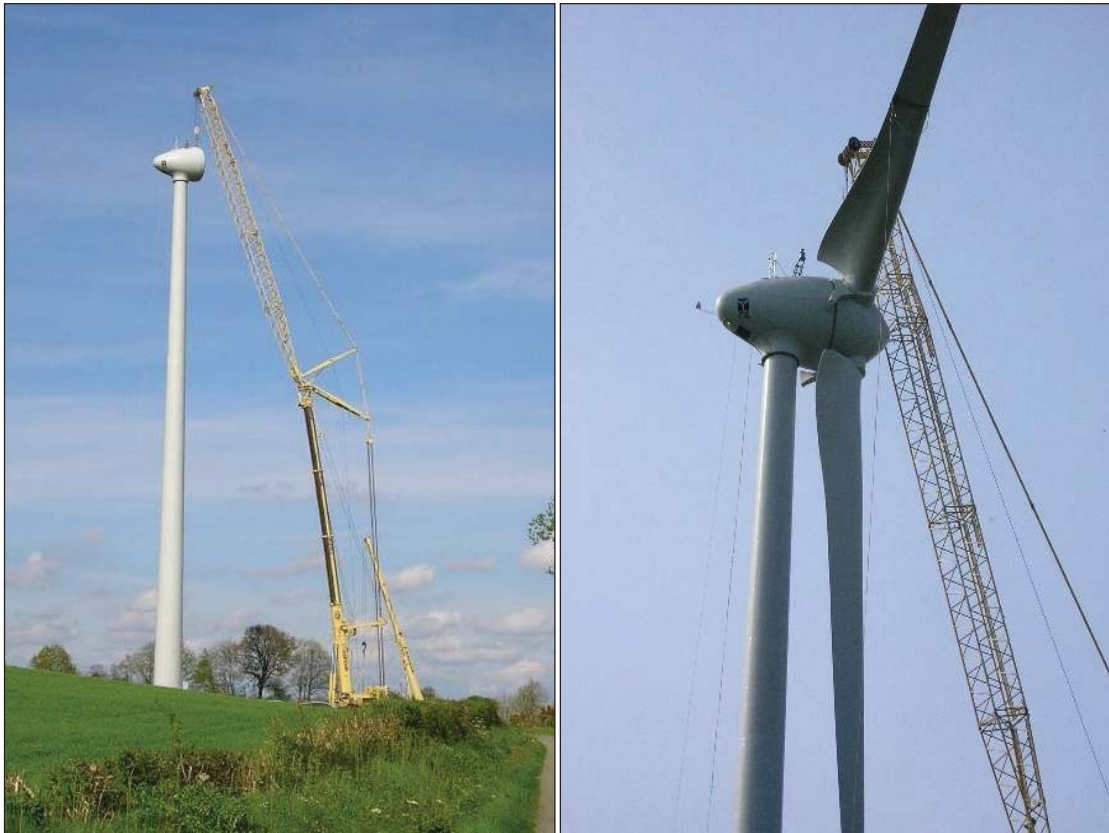
Photo 3.6 Installation de la nacelle et du rotor
