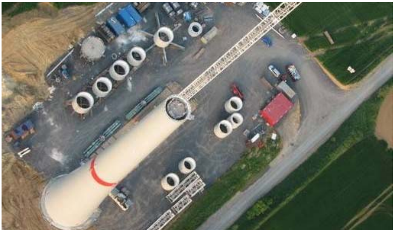
Photo 3.3 Aire de travail lors de l'érection de l'éolienne
