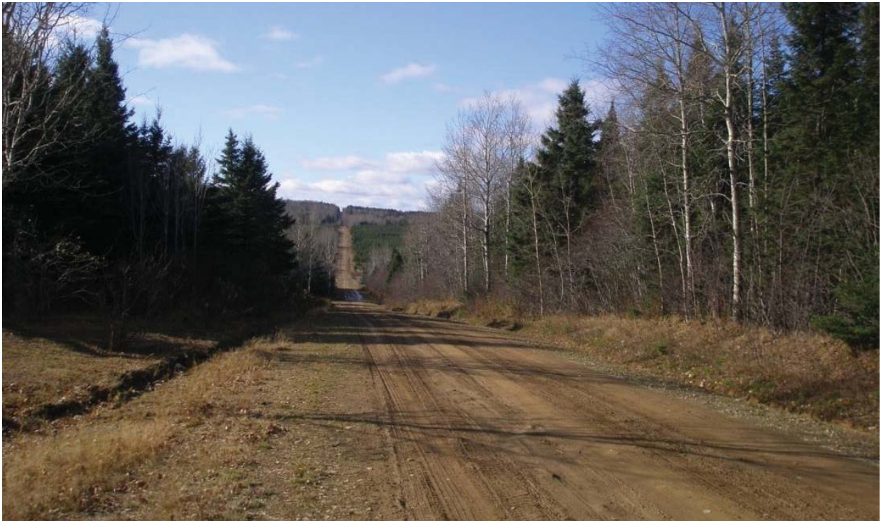
Photo 3.7 Chemin d'accès d'un parc éolien
