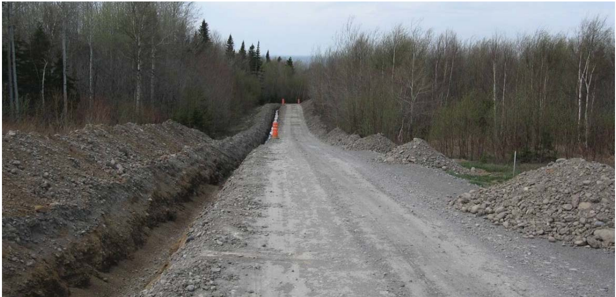
Photo 3.8 Tranchée requise pour l'enfouissement du réseau collecteur
