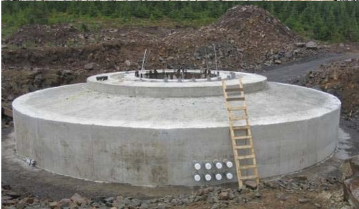
Photo 3.5 Fondation type d'une éolienne Enercon
