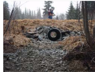
Réfection et installation de traverses de cours d'eau
