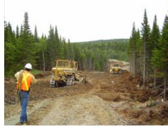
Construction des chemins
