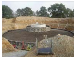
Installation de l'armature Entre 35 et 40 tonnes d'armature d'acier
