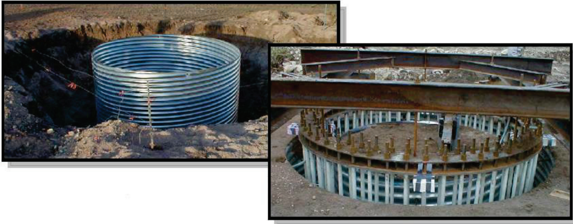
Figure 3.6 Fondation profonde annulaire
