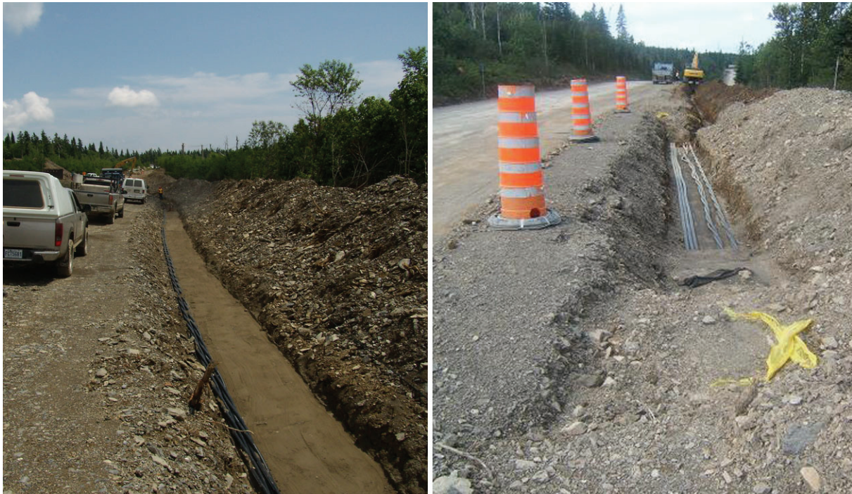
Figure 3.10 Installation des lignes électriques souterraines
