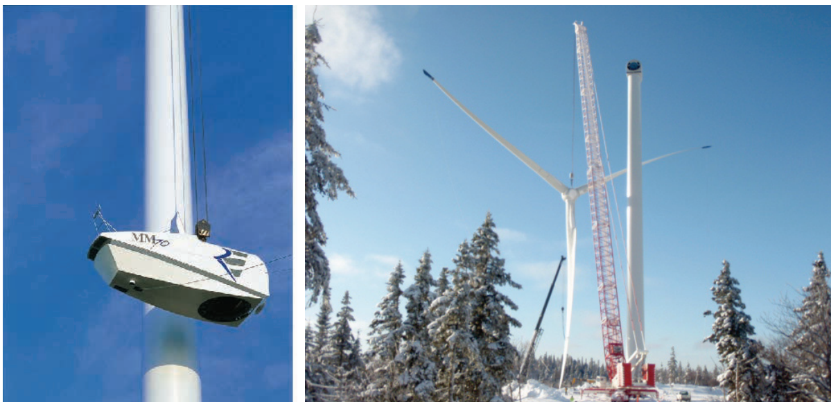
Figure 3.9 Assemblage d'une éolienne
