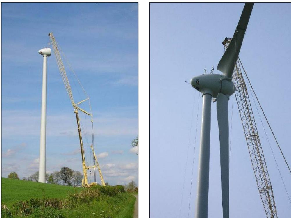
**Figure 3.7** Installation de la nacelle et du rotor
