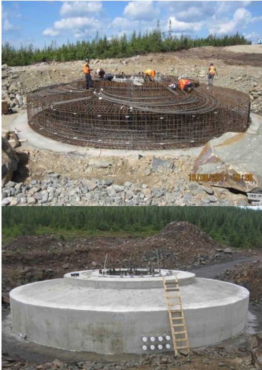
**Figure 3.6 Fondation type d'une éolienne Enercon**
