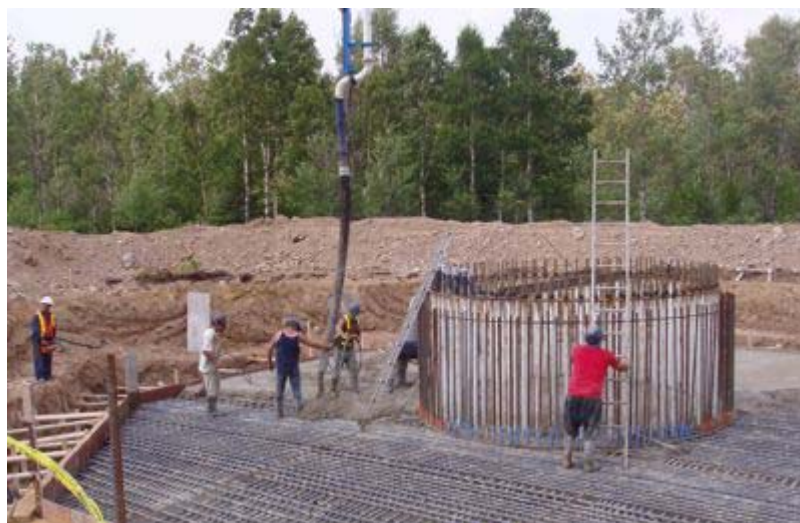
Figure 3.12 Fondation d'une éolienne avec ancrage pour la tour
