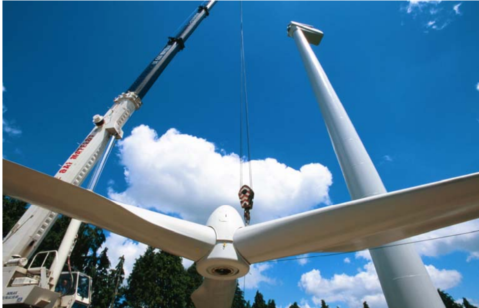
Figure 3.15 Levée du rotor
