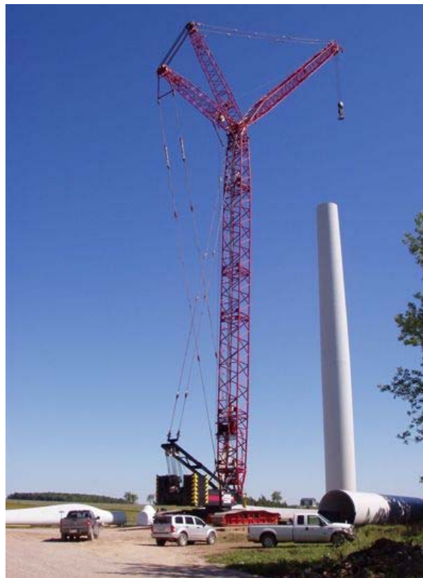
Figure 3.13 Montage de la tour
