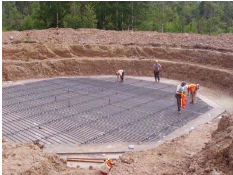
Figure 3.11 Fondation d'une éolienne
