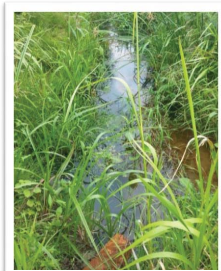
Drain souterrain se jetant dans le cours d'eau.
