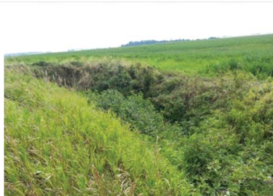
C-5. Site de traversée de cours d'eau.
