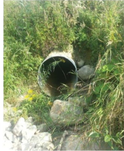
C-12. Site de traversée de cours d'eau.
