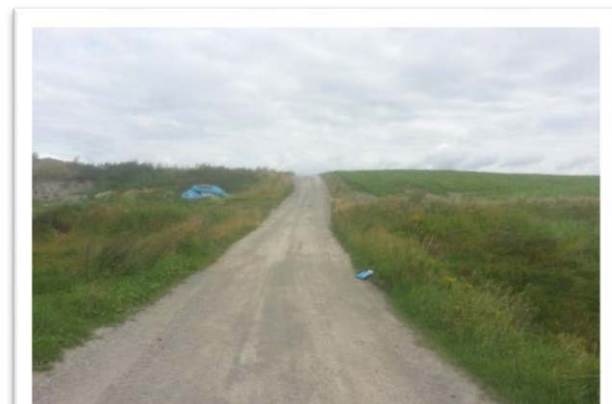
Chemin existant, aménagé d'une traverse.
