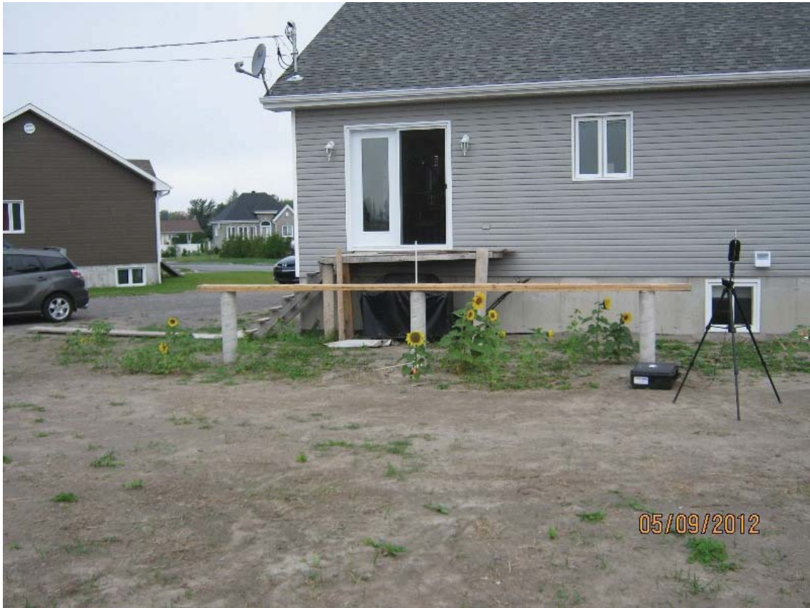
Figure A5 Le point de mesure P5 est localisé au sud de la maison située au 138, rue Girard
