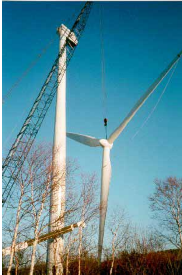
Figure 3.5 Montage du rotor à la nacelle
