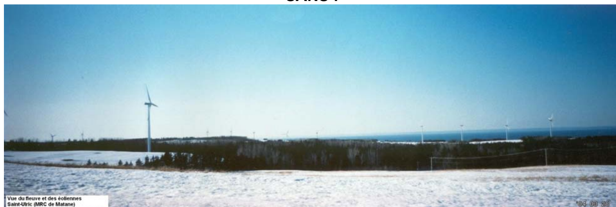
Crédit photographique : Julie Potvin, Baie-des-Sables
