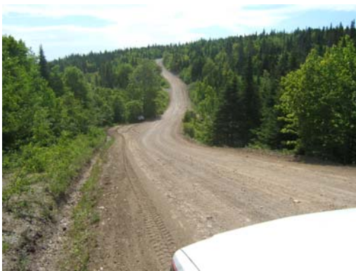
Figure 3. Chemin d'accès de la Pointe-à-la-Renommée
