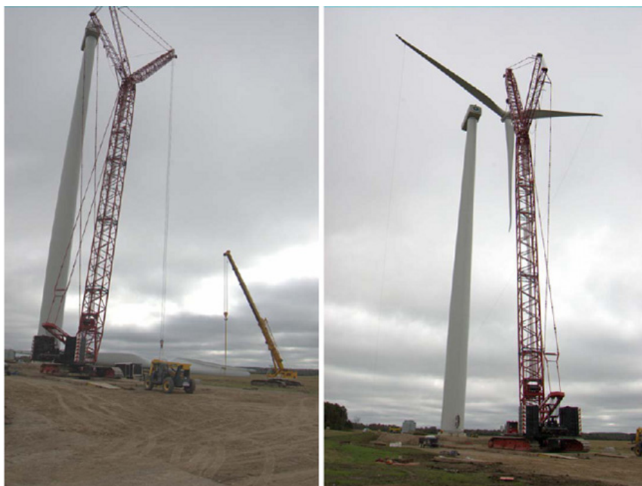
Figure 2.1-7 : Installation du rotor d'une éolienne
