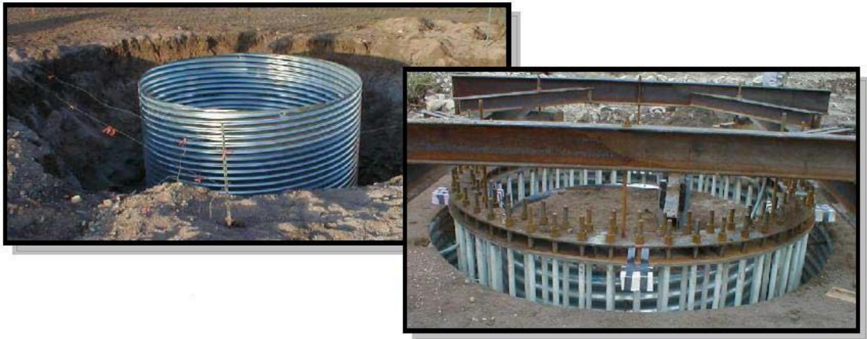
Figure 3.7 Fondation profonde annulaire
