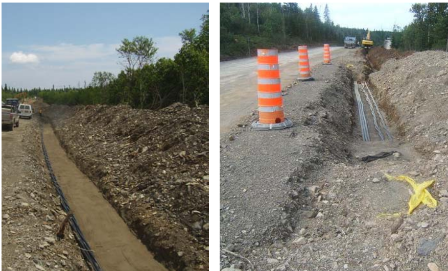
Figure 3.10 Installation des lignes électriques souterraines
