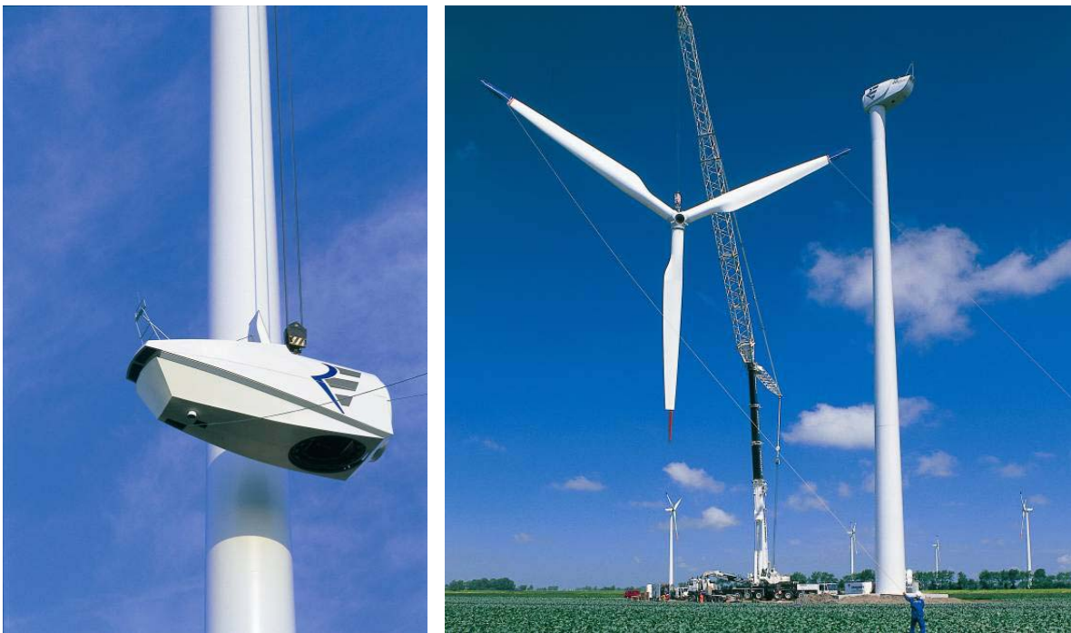
Figure 3.9 Assemblage d'une éolienne
