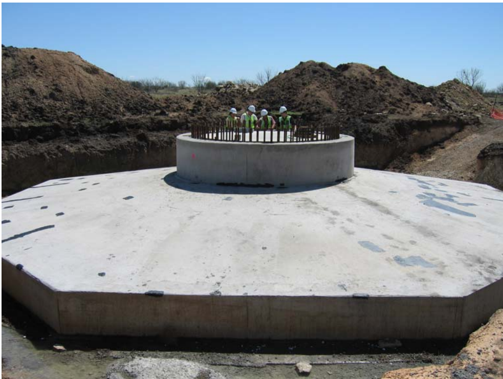
Figure 3.6 Fondation de masse (ou superficielle)
