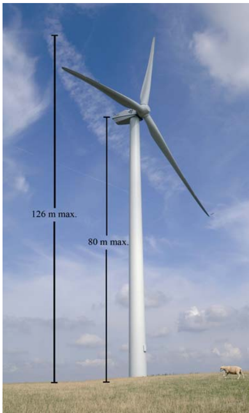
Figure 3.5 Dimension d'une éolienne REpower MM92
