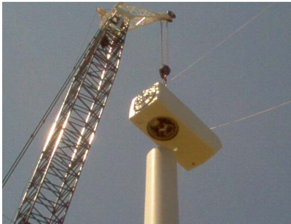
Figure 3.19 Montage de la nacelle
