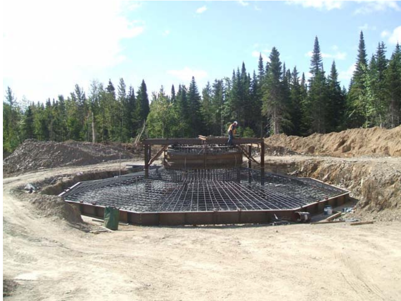
Figure 3.16 Fondation d'une éolienne
