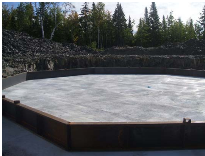
Figure 3.15 Dalle de propreté
