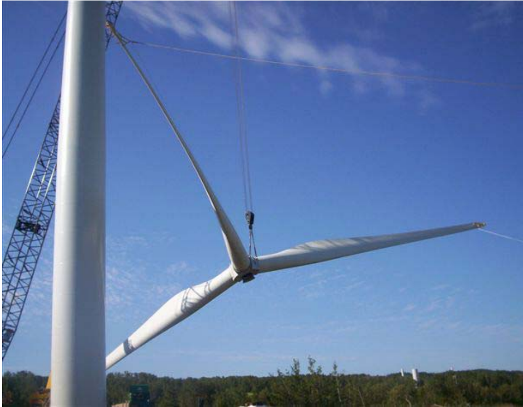
Figure 3.20 Levée du rotor
