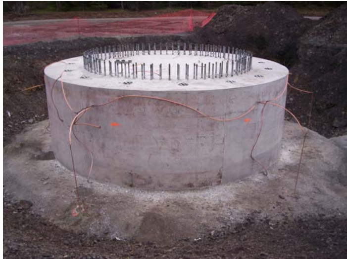
Figure 3.14 Fondation ancrée au roc
