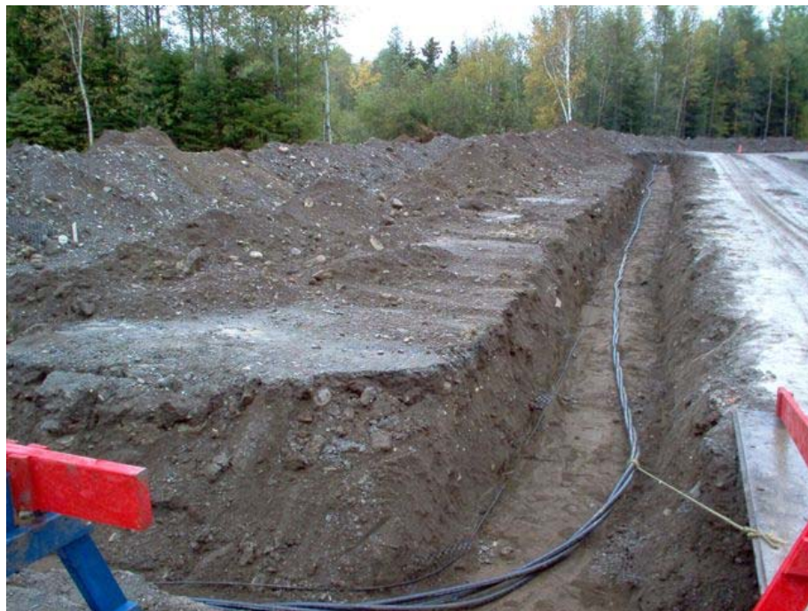
Figure 3.9 Lignes électriques souterraines
