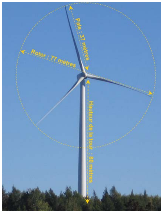
Figure 3.4 Composantes et dimension d'une éolienne GE 1,5 sle 60 Hz
