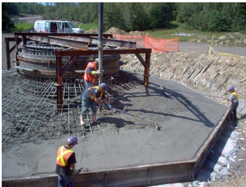
Figure 3.17 Coulée de béton
