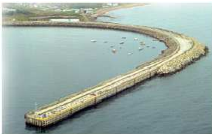
Figure 17 : Port de Chandler 22
