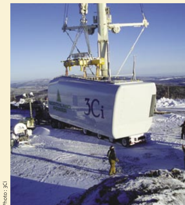
Levée d'une nacelle dans un parc à Murdochville.
