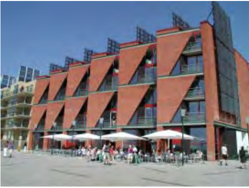
Des capteurs solaires fournissent le complément de calories nécessaire au chauffage et à la production d'eau chaude sanitaire des bâtiments.
