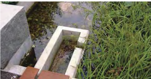
Les eaux pluviales sont évacuées progressivement grâce à des toitures végétalisées. Elles sont ensuite collectées par des rigoles qui rejoignent un canal à ciel ouvert. Celui-ci est bordé de milieux humides qui accueillent de nombreuses espèces animales et végétales.
