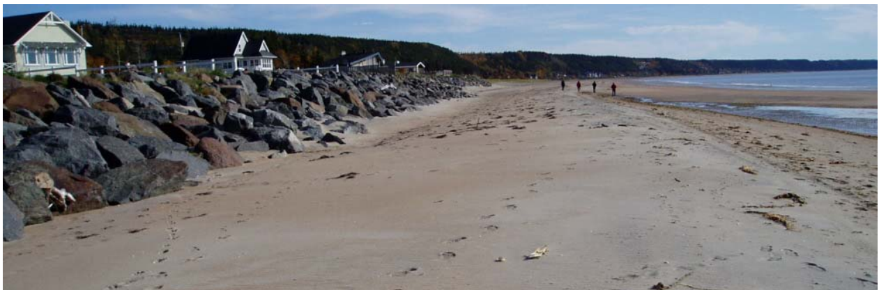
Figure 2.15 Enrochement de protection de berge – Plage Routhier (vers l'est) en septembre 2006
