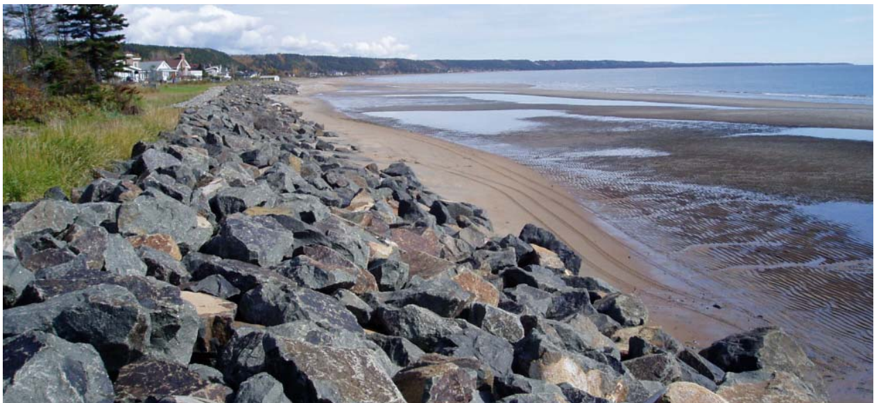
Figure 2.13 Enrochement de protection de berge – Plage Fergusson (vers l'est)
