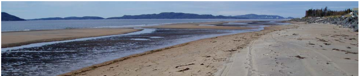
Figure 2.5 Rétrécissement de la plage Fergusson devant les enrochements (vers l'ouest)
