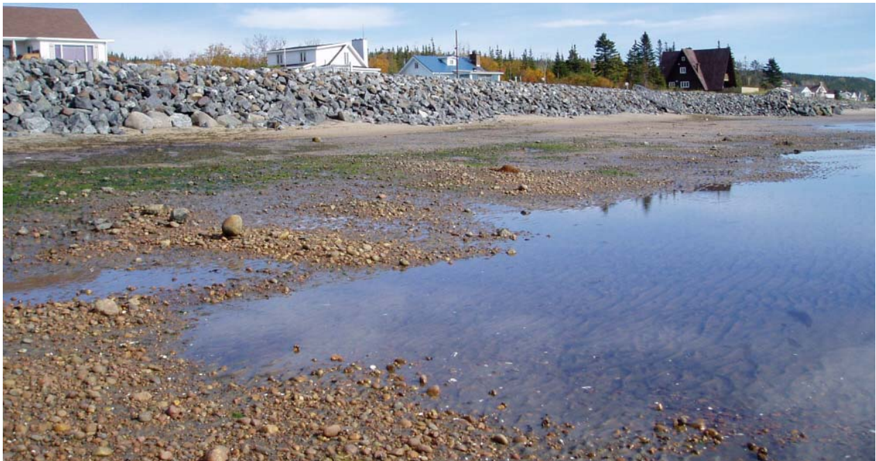
Figure 2.7 Vue de l'avant plage devant les enrochements temporaires de 2005 (Fergusson vers l'est)
