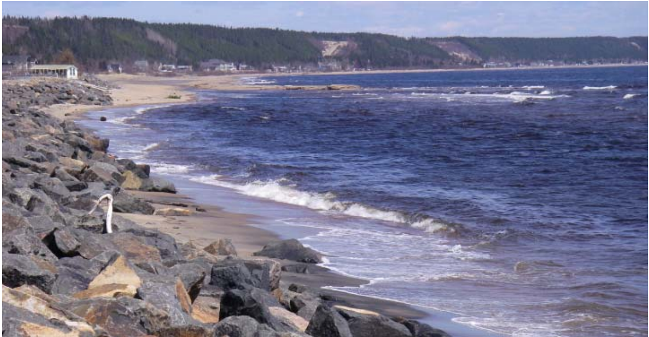
Figure 2.14 Enrochement de protection de berge – Plages Fergusson et Routhier (vers l'est) en mai 2007
