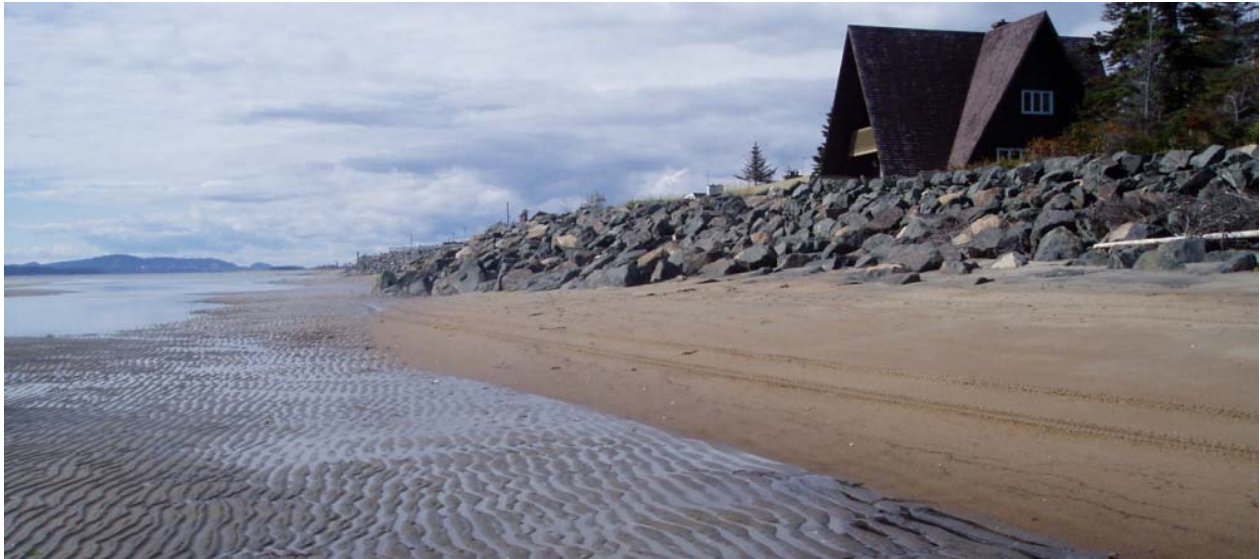
Figure 2.6 Épi formé par l'extrémité ouest des travaux d'enrochement de 2004
