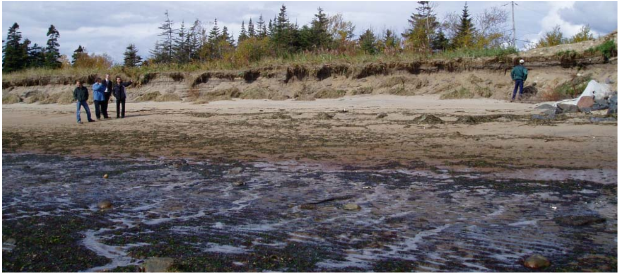
Figure 2.10 Érosion de berge immédiatement à l'ouest de l'enrochement temporaire de 2005
