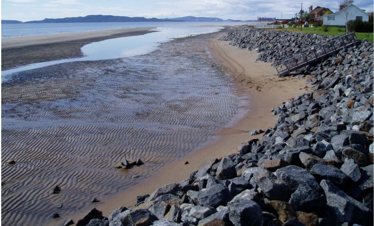
Figure 2.12 Enrochement temporaire de protection de talus – Plage Fergusson (vers l'ouest)
