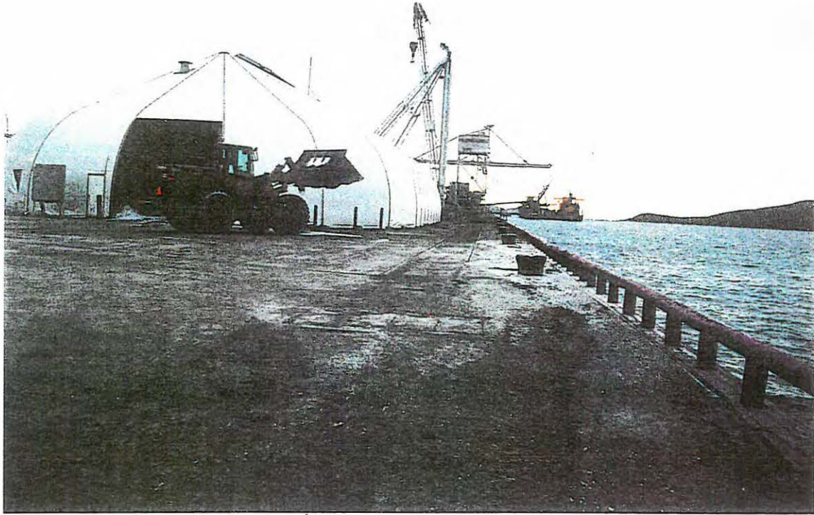
Vue du secteur du dépôt à sel
