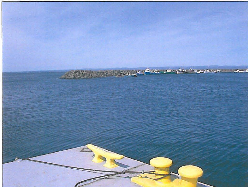
Photo 2. Vue du brise-lames (jetée du parc de pêche)
