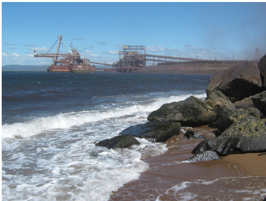
Figure 4 Photographie de la zone entre l'entrée du Bassin des Remorqueurs et le quai n 2, printemps 2010.
