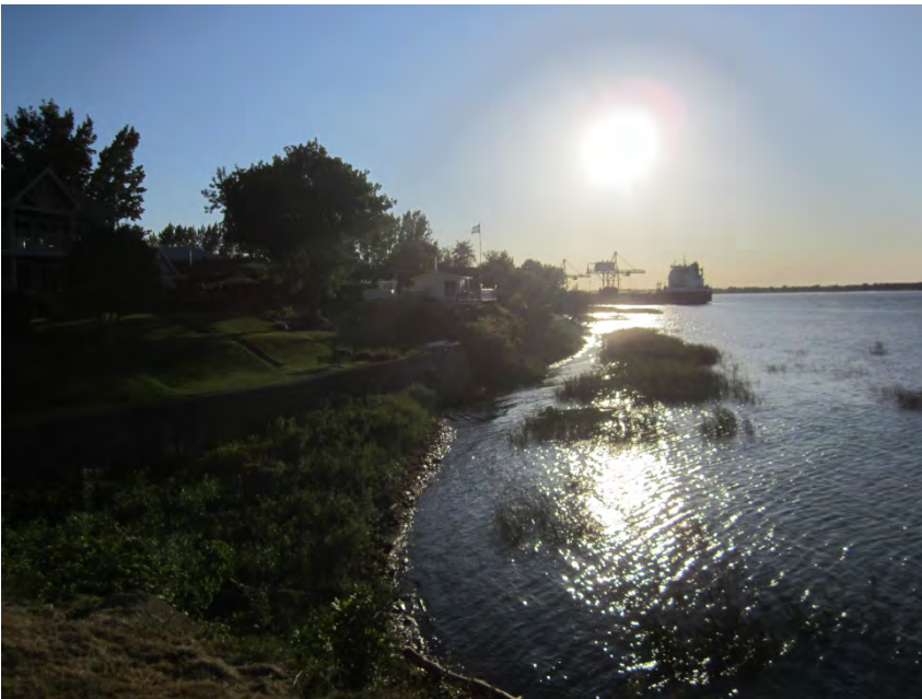
Figure 3-7 Unité de paysage No. 3 : Vue du secteur résidentiel et des installations de RTFT à partir du parc de la Pointe-aux-Pins.
