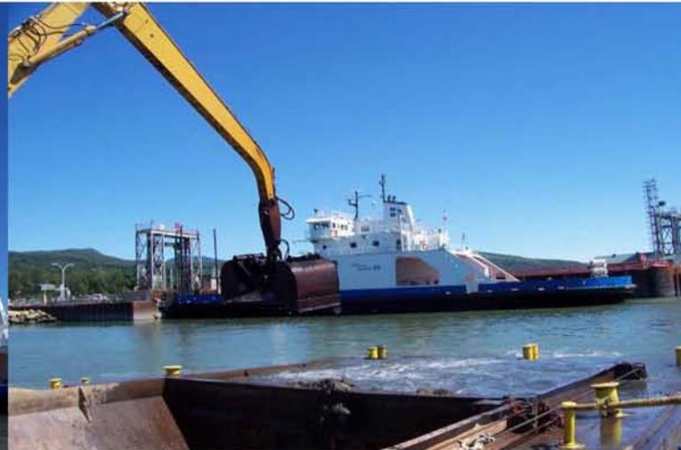
Les sédiments sont déposés sur un chaland qui sera auto-déchargeur remorquée jusqu'au site de mise en dépôt
