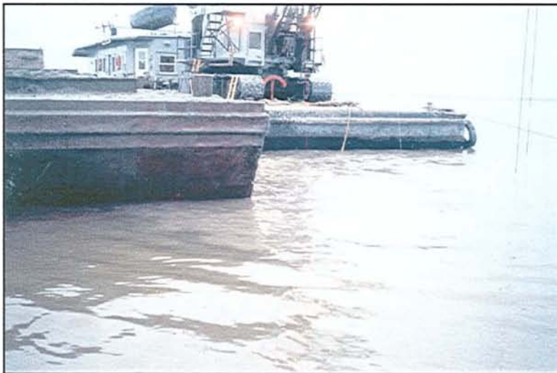
3. Superficie affectée directement par les travaux (2e journée du suivi)
