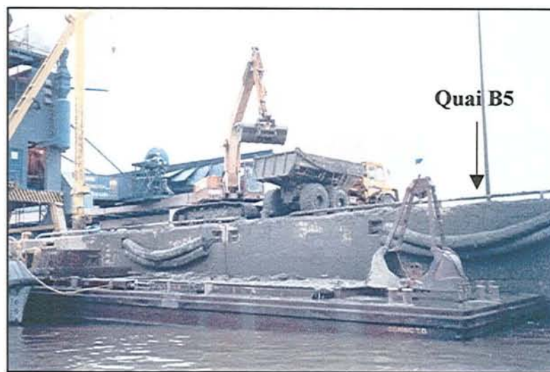
6. Transbordement des sédiments à l'aide d'une grue
