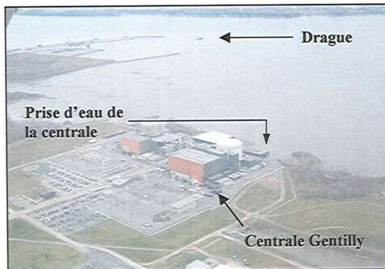
11. Photo aérienne du site, direction nord-ouest (1 e journée du suivi)
