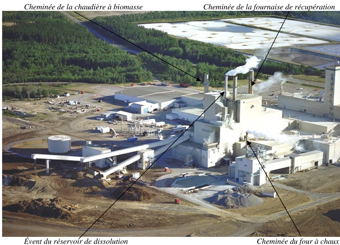
Figure 5.2 Vue d'ensemble du site et des principales cheminées de l'usine.
