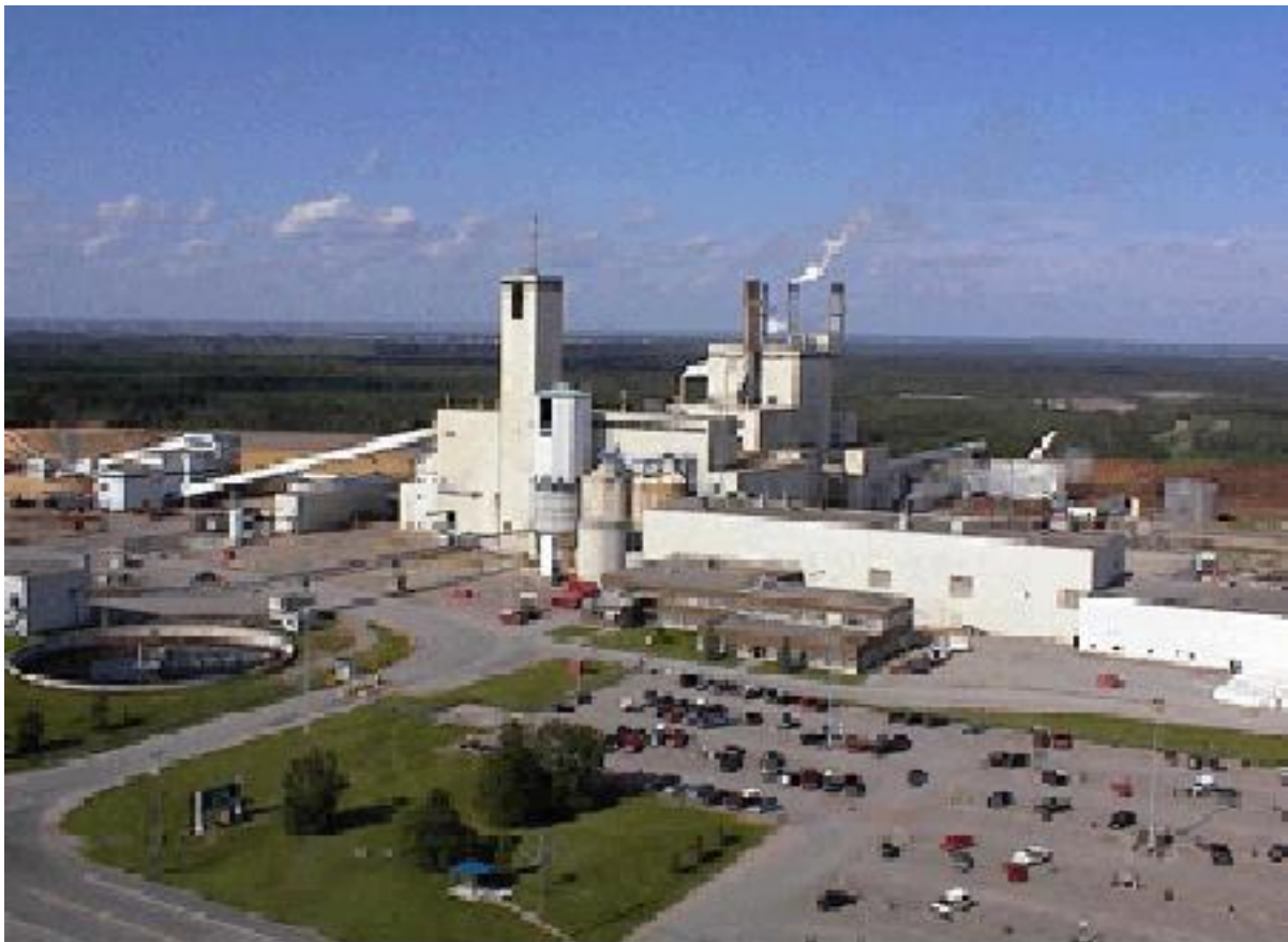
Figure 2.1 Vue générale de l'usine SFK de Saint-Félicien.
