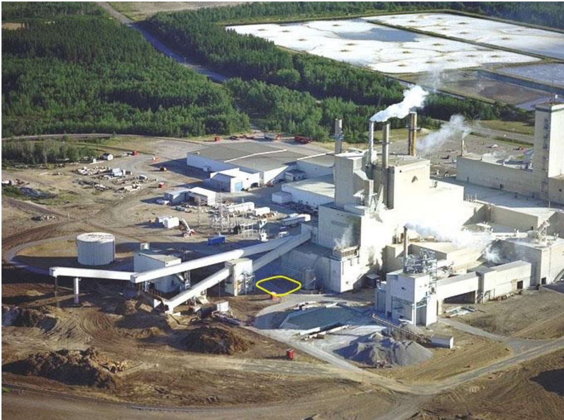
Photo A4.1 Vue de l'arrière de l'usine et emplacement de la future centrale
