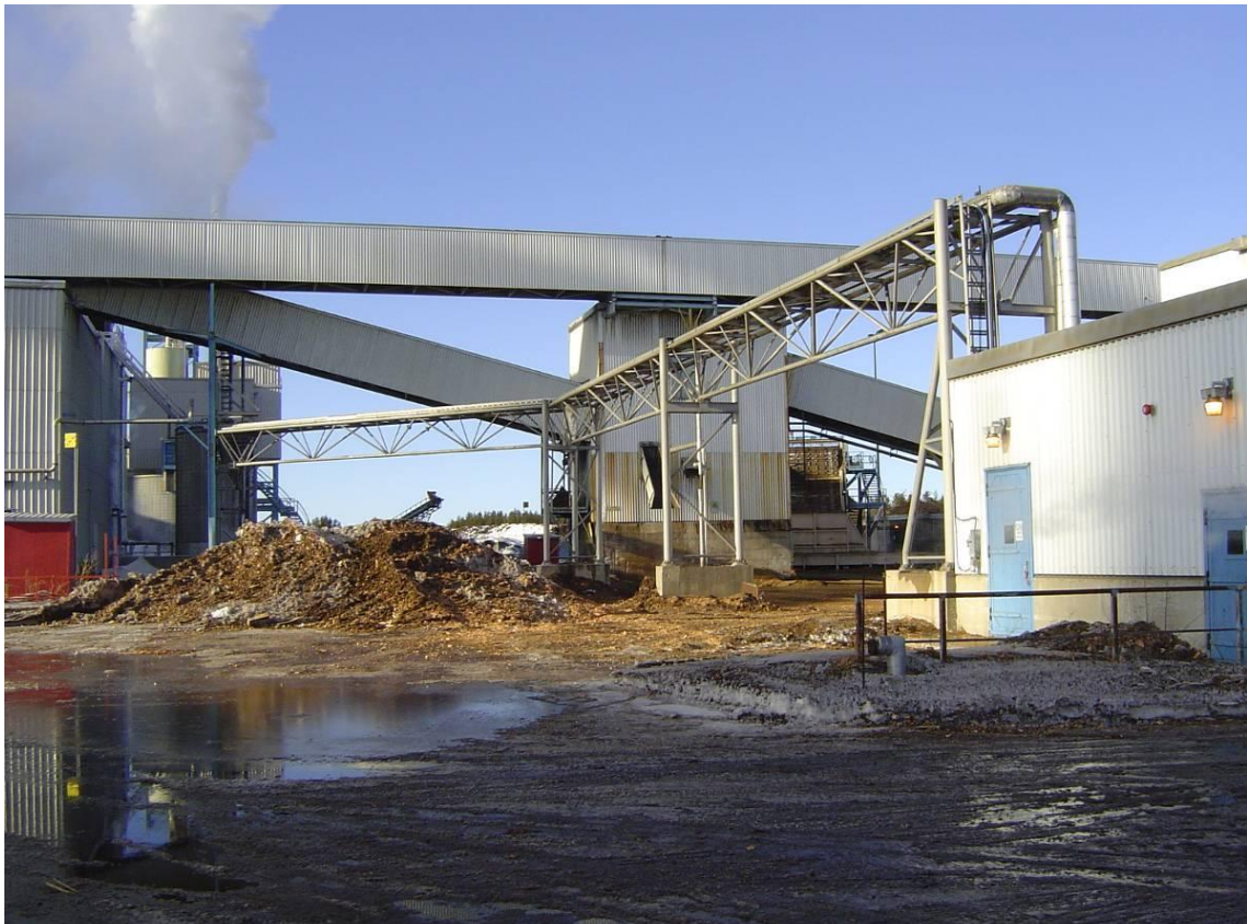
Photo A4.4 Vue sous les convoyeurs où le nouveau bâtiment doit être construit
