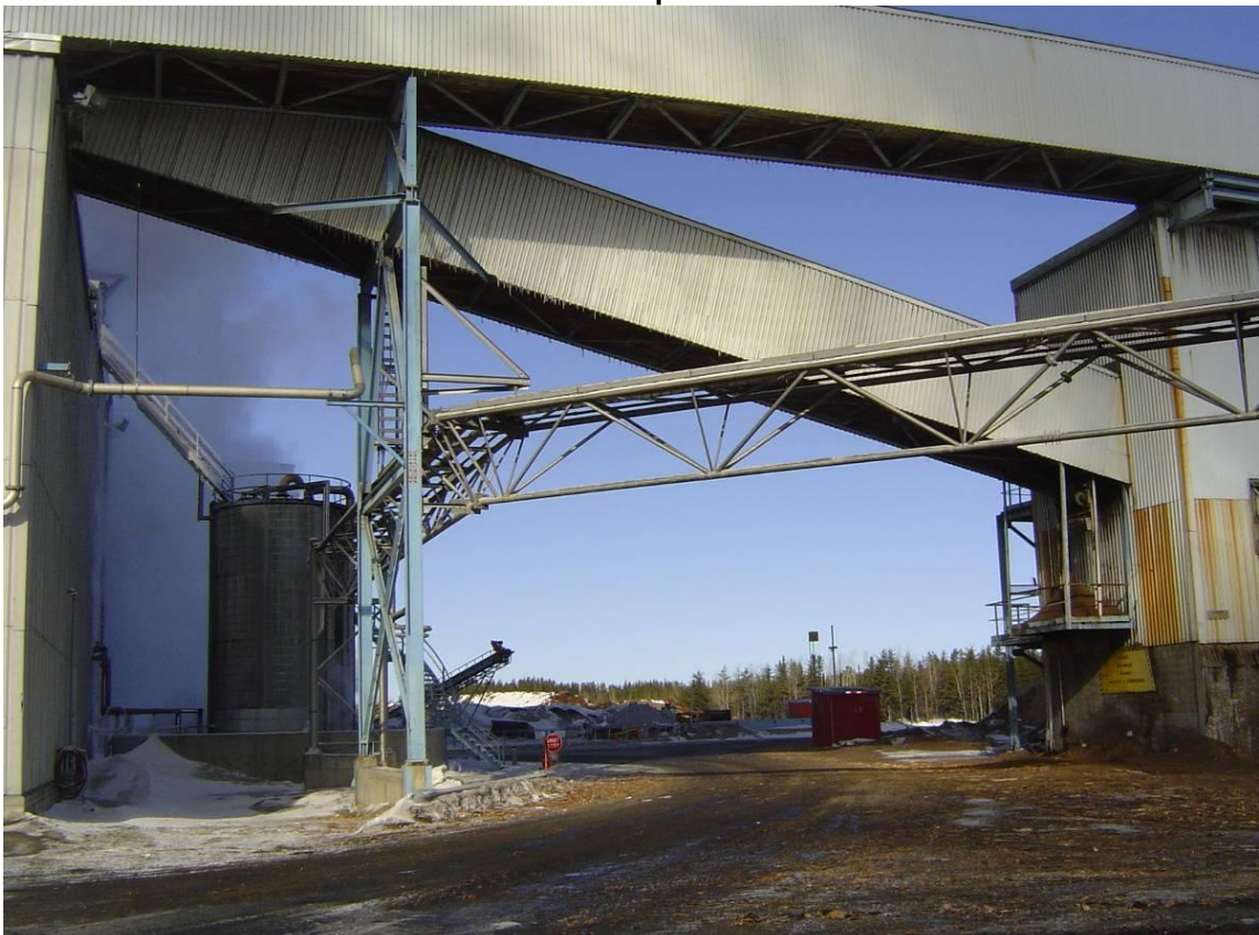
Photo A4.2 Vue rapprochée de l'emplacement de la future centrale
