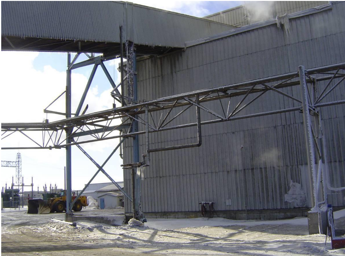
Photo A4.3 Mur arrière de l'usine où le nouveau bâtiment doit être construit
