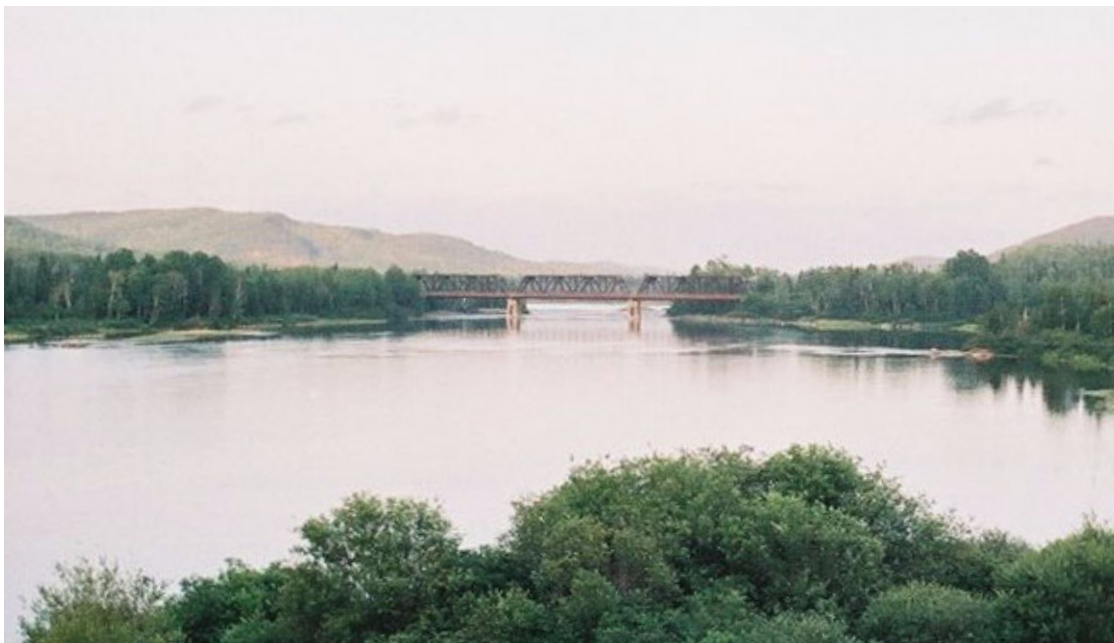
Figure 28-1 Pont ferroviaire entre Sanmaur et Wemotaci
