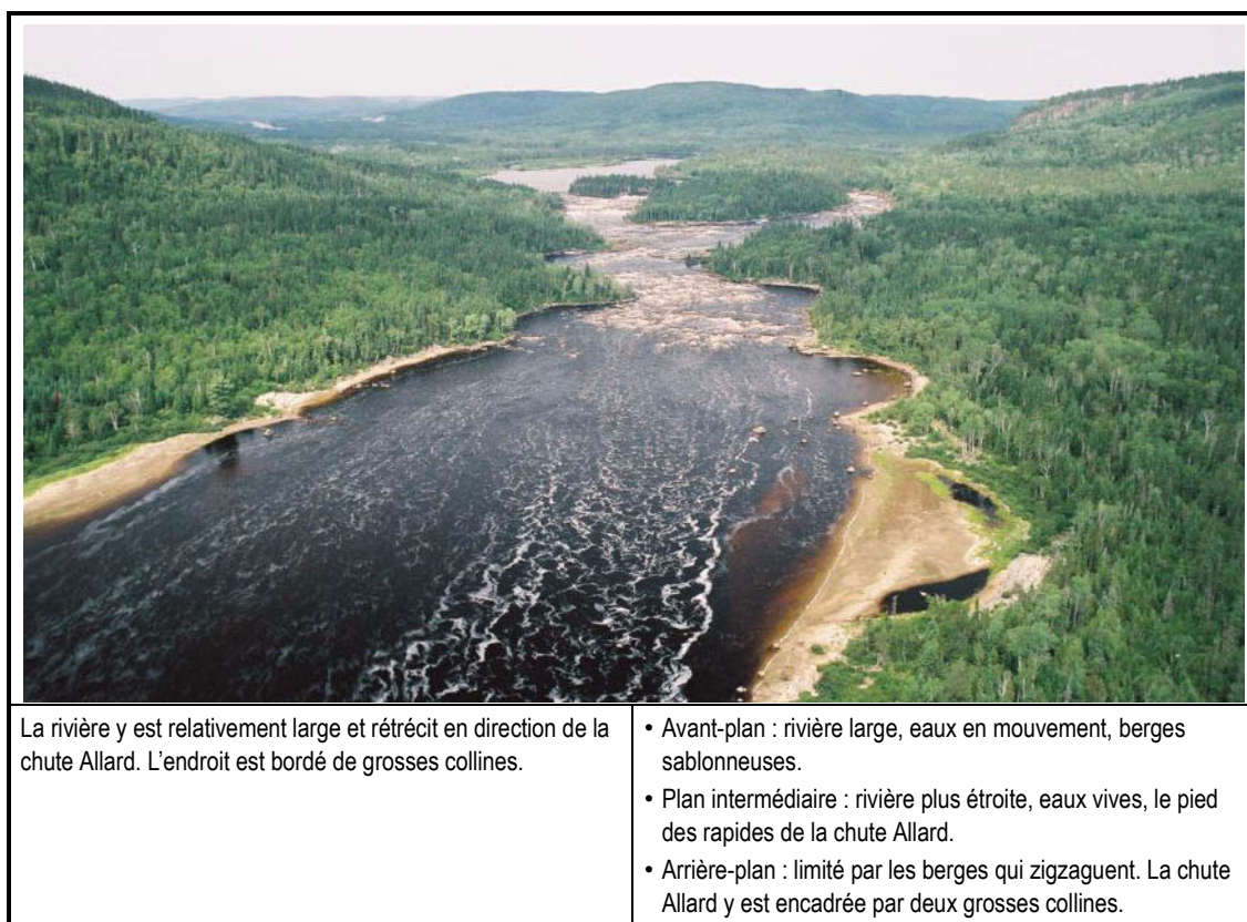
Figure U-7 Vue vers l'amont sur les rapides des Cœurs – PK 296,5
