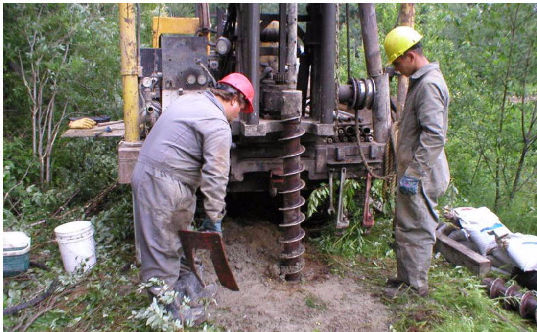
Figure 24-2 Forage d'un puits pour l'analyse de l'eau souterraine au dépôt en tranchée de Wemotaci
