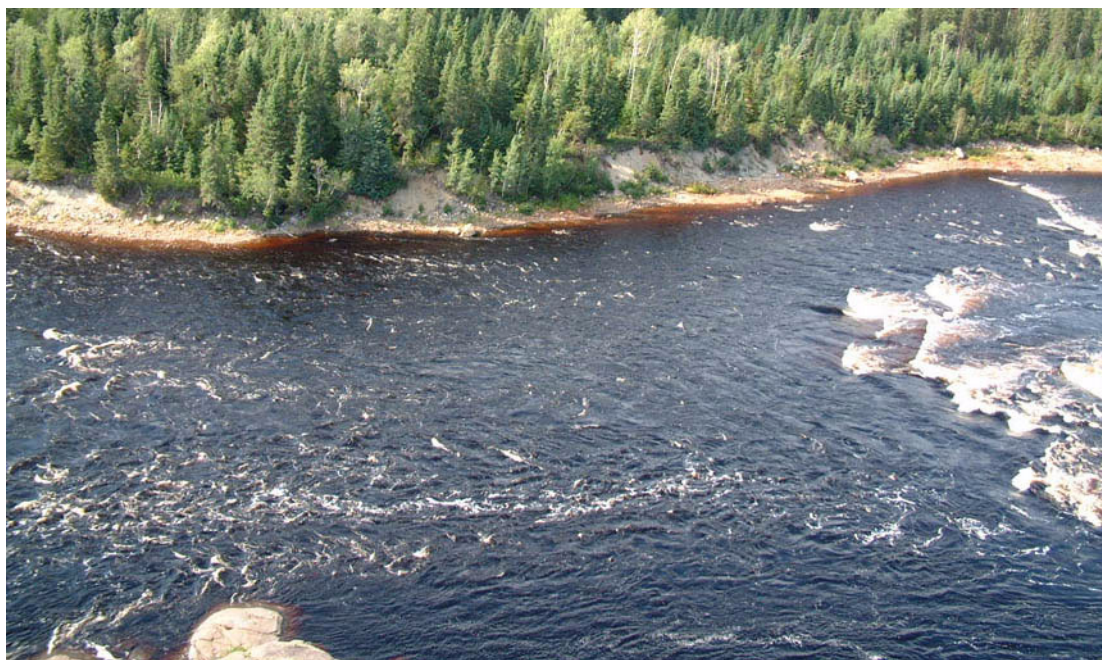
Figure 9-1 Talus de cailloux et de blocs en érosion au PK 302,4 en rive gauche du Saint-Maurice
