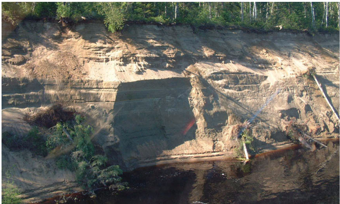
Figure 9-2 Talus de sable en érosion au PK 274,3 en rive droite du Saint-Maurice
