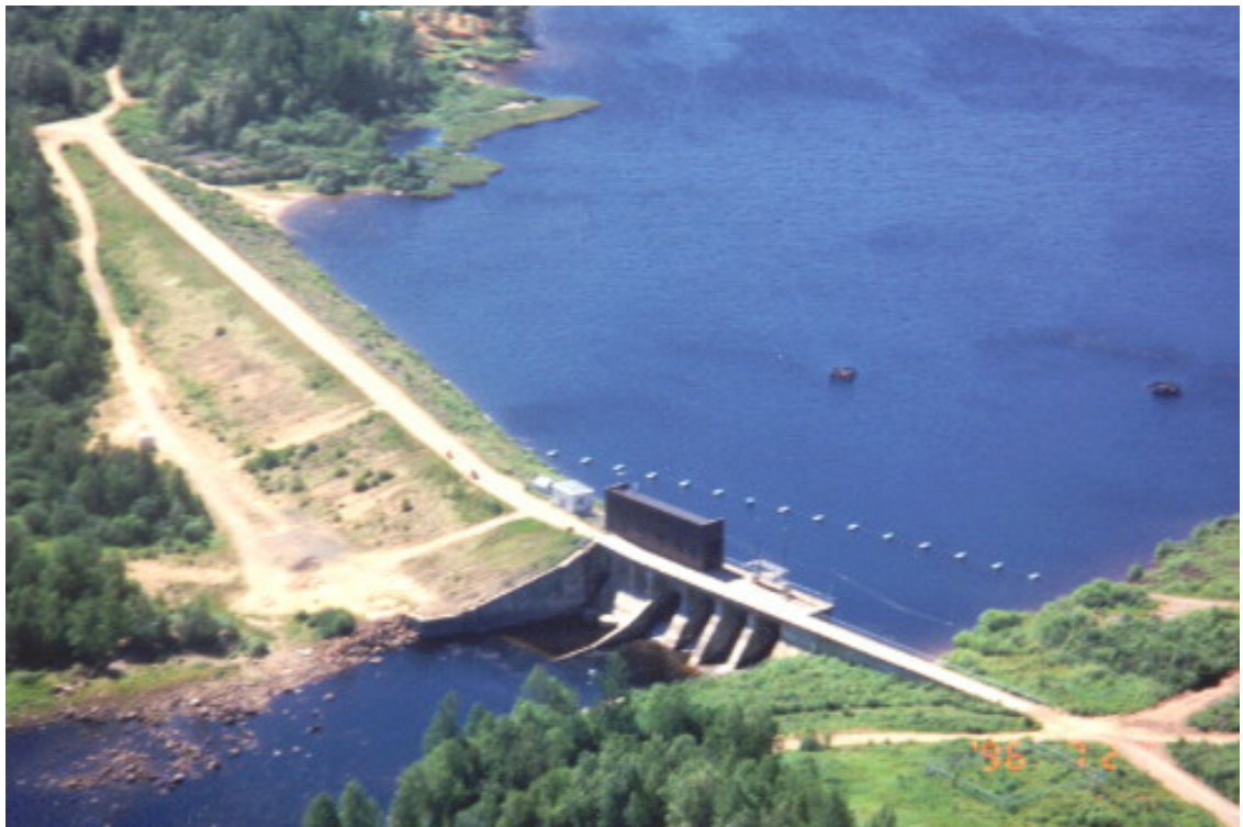
Figure 18 Photo du barrage de la Manouane-C
