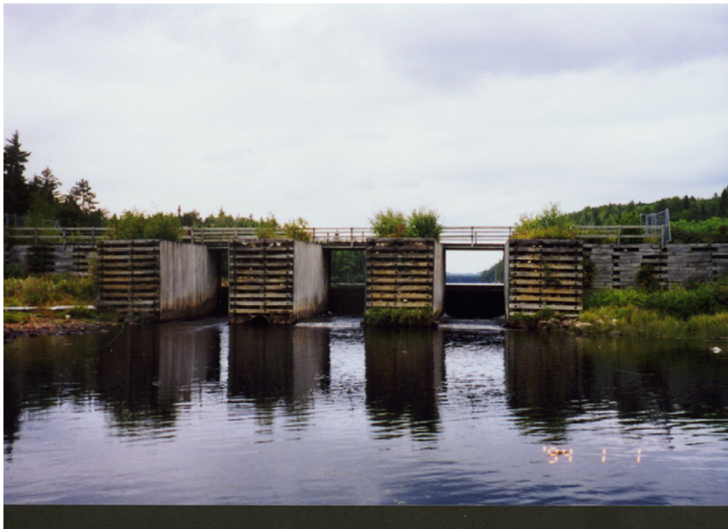
Figure 42 Photo du barrage du Soucis
