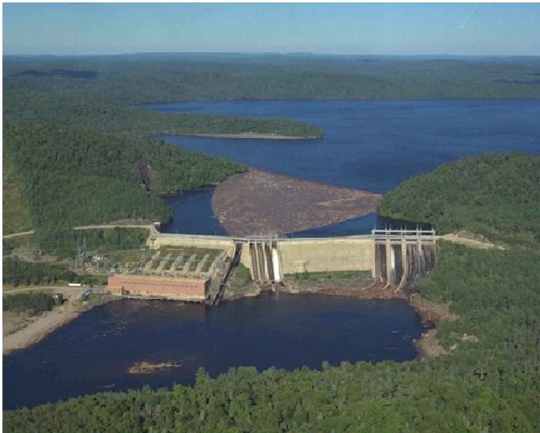
Figure 12 Photo de la centrale de la Trenché
