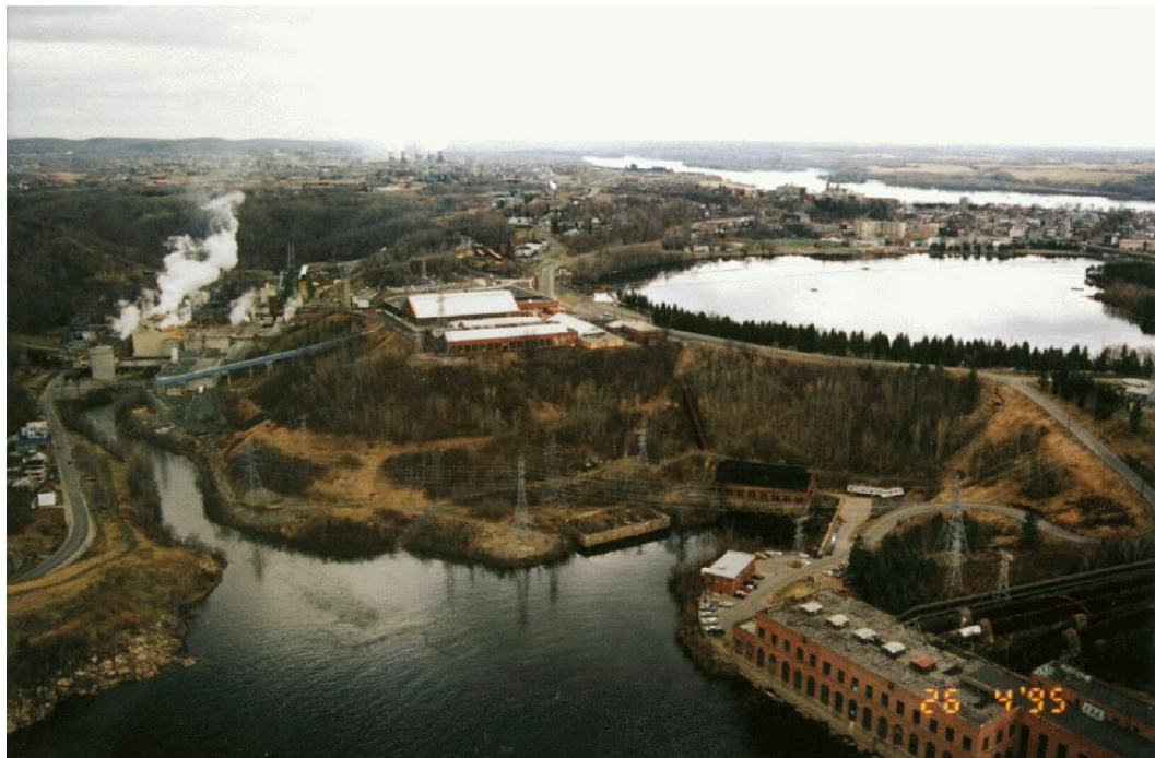
Figure 52 Photo du Talus Belgo
