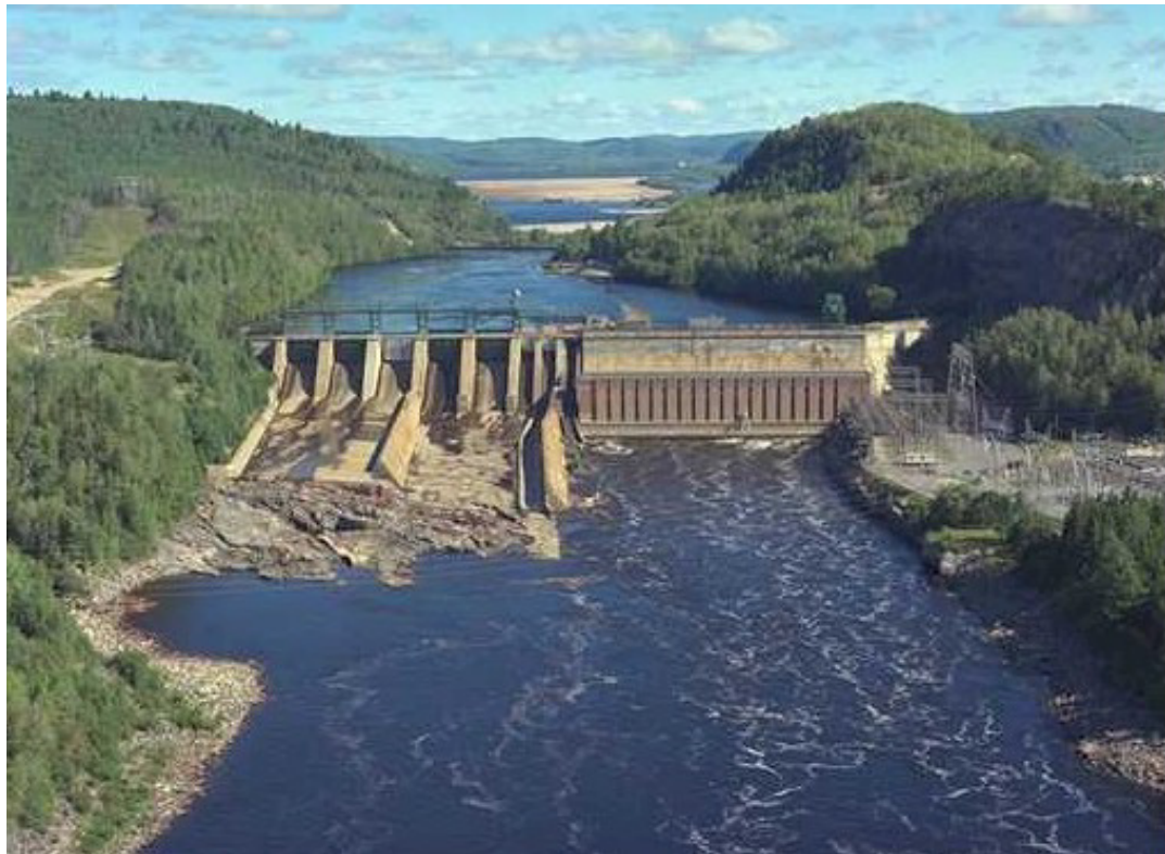
Figure 28 Photo de la centrale de La Tuque
