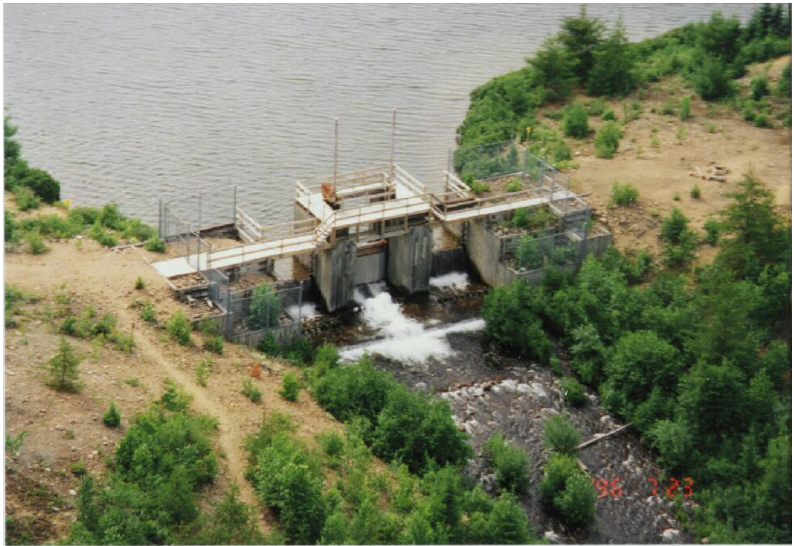
Figure 30 Photo du barrage du Normand
