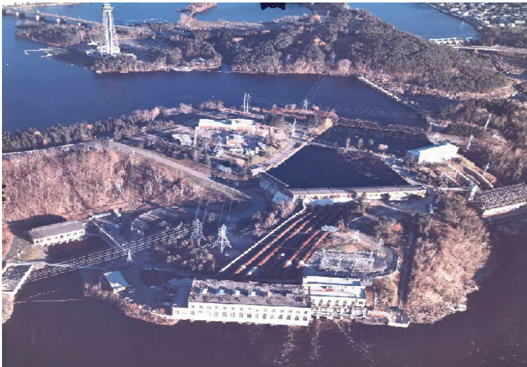
Figure 48 Photo de l'aménagement de Shawinigan-2
