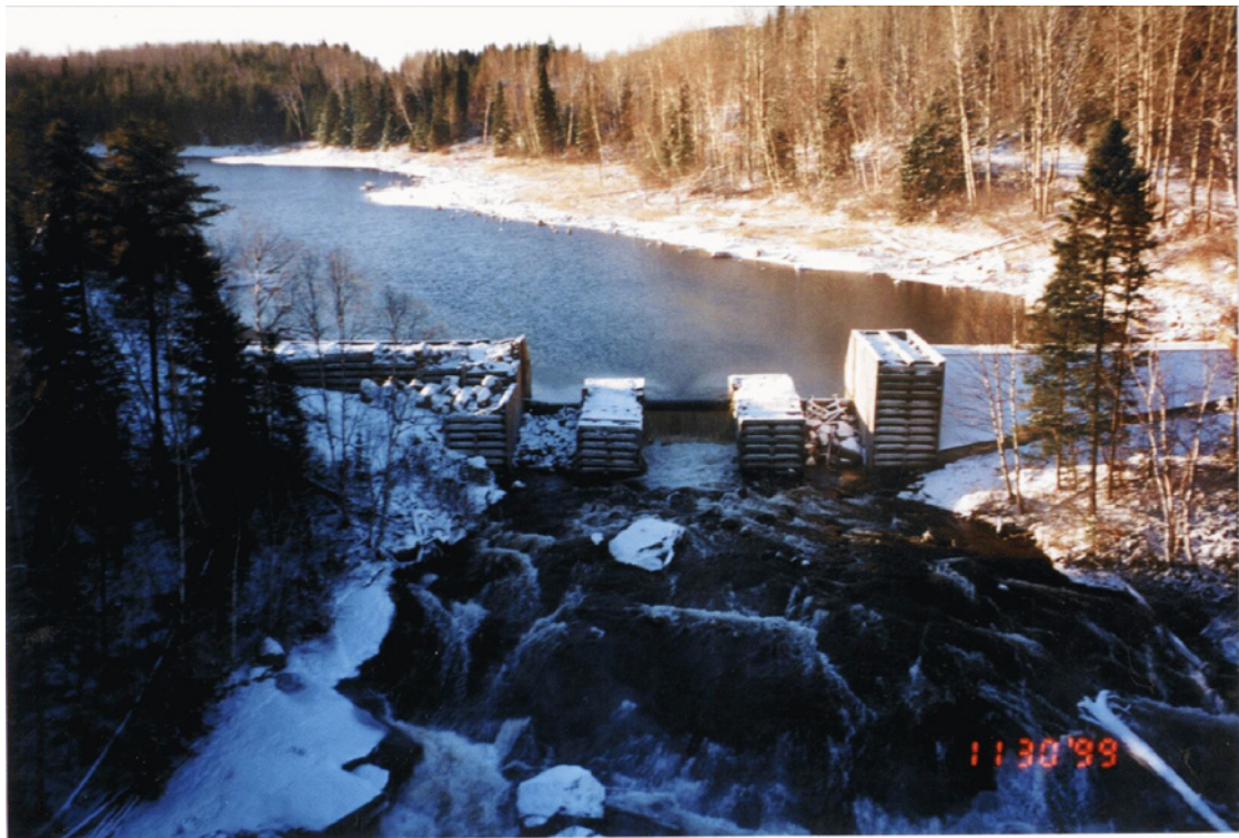
Figure 20 Photo du barrage de la Mondonac
