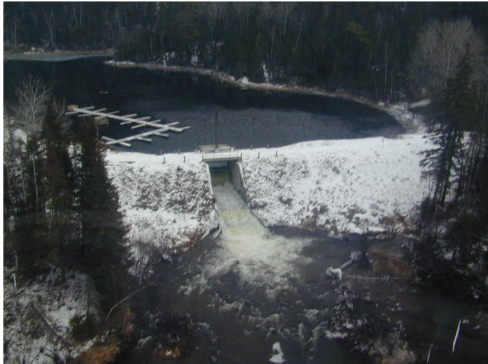
Figure 39 Photo du barrage du Cinconsine
