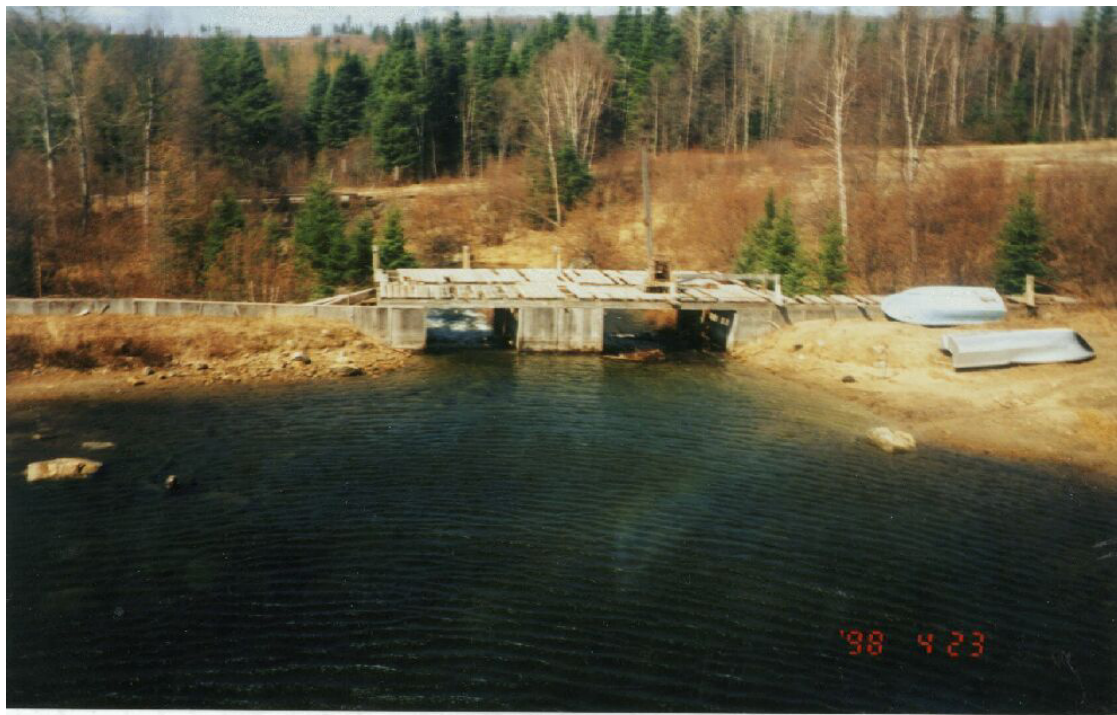
Figure 22 Photo du barrage Sincennes
