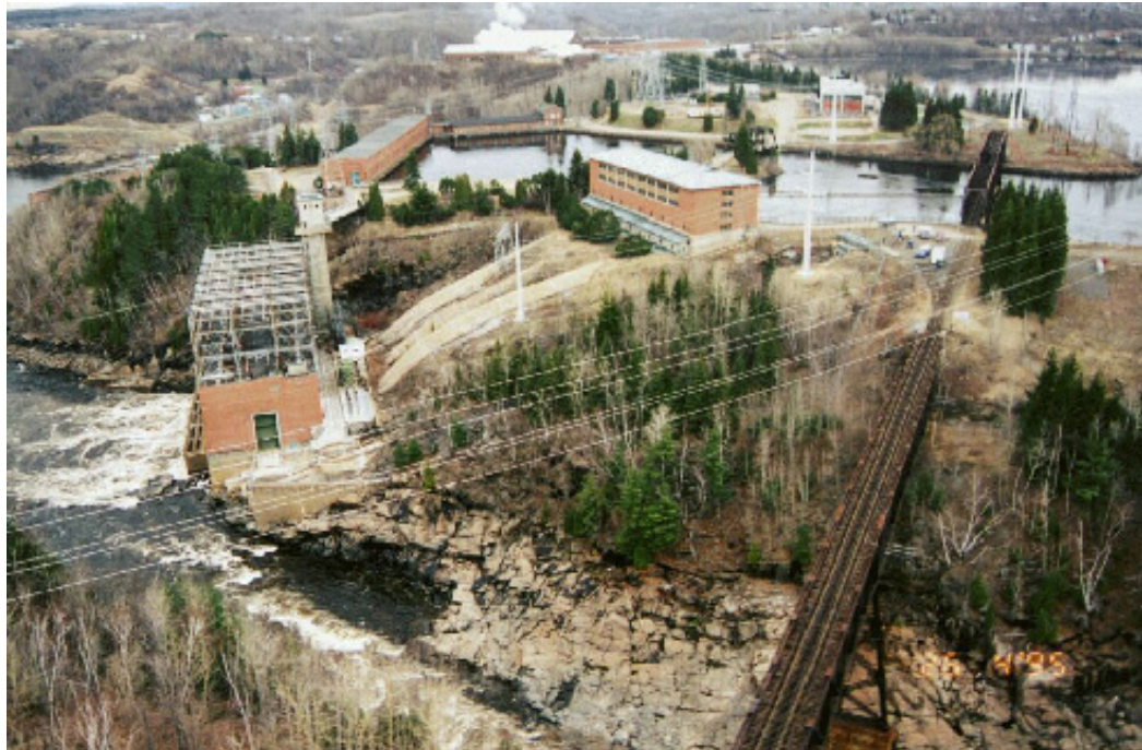
Figure 49 Photo de l'aménagement de Shawinigan-3
