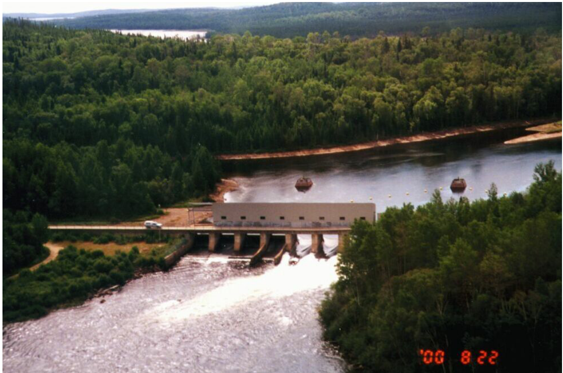
Figure 16 Photo du barrage de la Manouane-B
