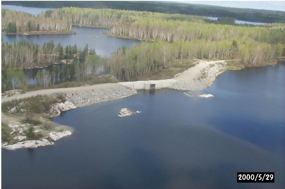
Figure 9 Photo du barrage de la Mégiscane
