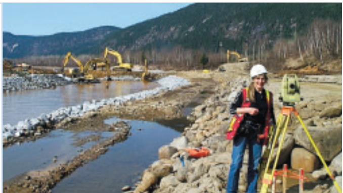
Une arpenteuse-géomètre au chantier de la Toulnostouc
