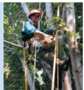
Travaux d'élagage sur le réseau de distribution
