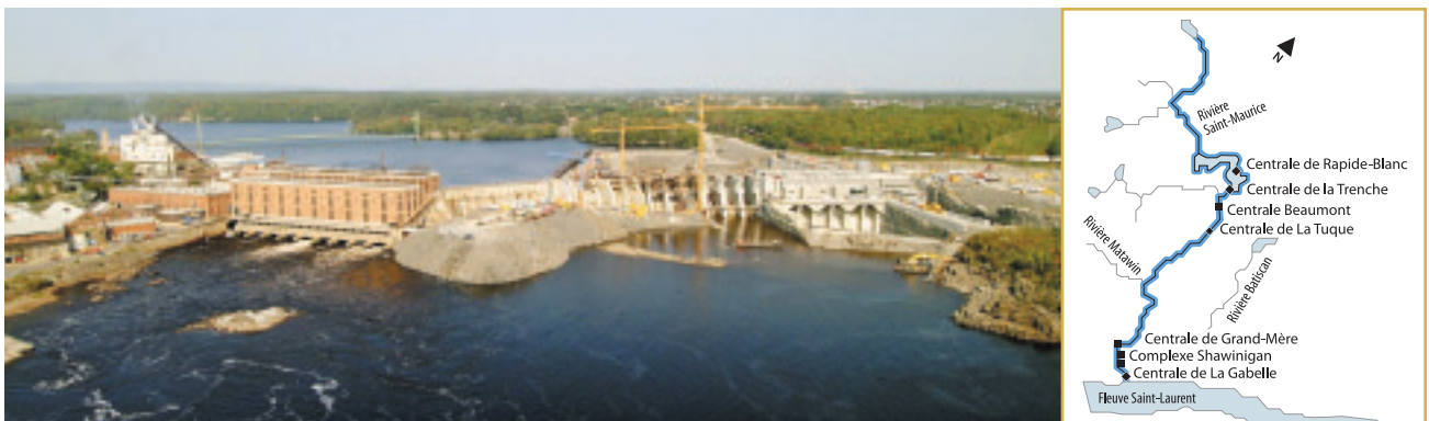
Deux centrales voisines, Grand-Mère et Rocher-de-Grand-Mère (en construction)
