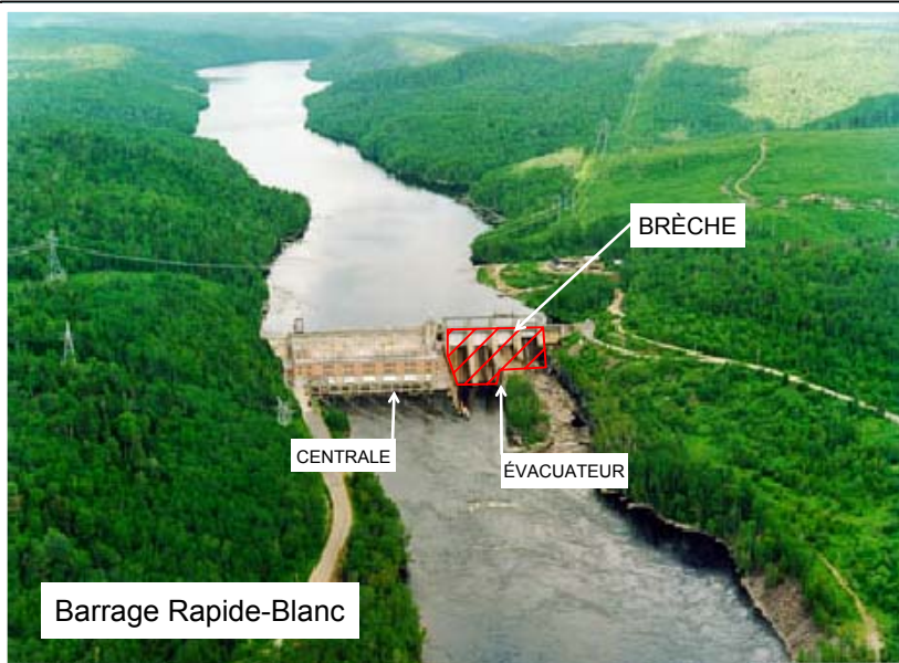
FIGURE 3.4 - DESCRIPTION DE LA BRÈCHE AU BARRAGE RAPIDE-BLANC
