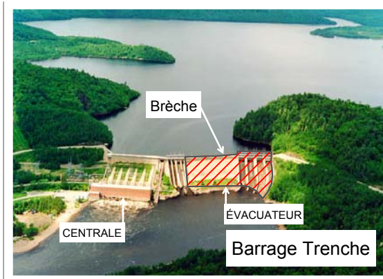
FIGURE 3.5 - DESCRIPTION DE LA BRÈCHE AU BARRAGE TRENCHÉ
