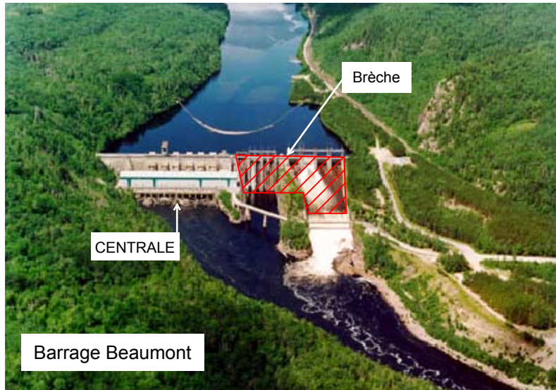
FIGURE 3.6 - DESCRIPTION DE LA BRÈCHE AU BARRAGE BEAUMONT
