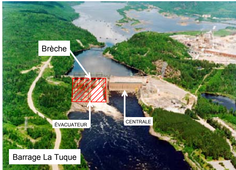
FIGURE 3.7 - DESCRIPTION DE LA BRÈCHE AU BARRAGE LA TUQUE
