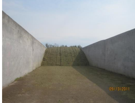
Figure 13 Silo-fosse avec ensilage de foin
