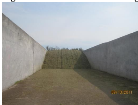
Figure 26 Silo-fosse avec ensilage de foin
