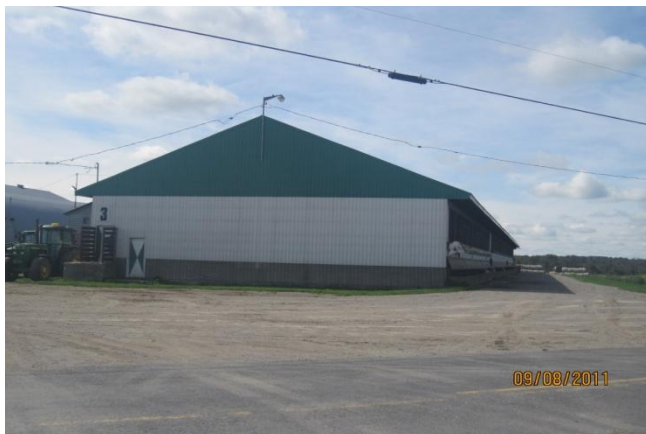
Figure 15 Bâtiment Ferme Cinco inc.
