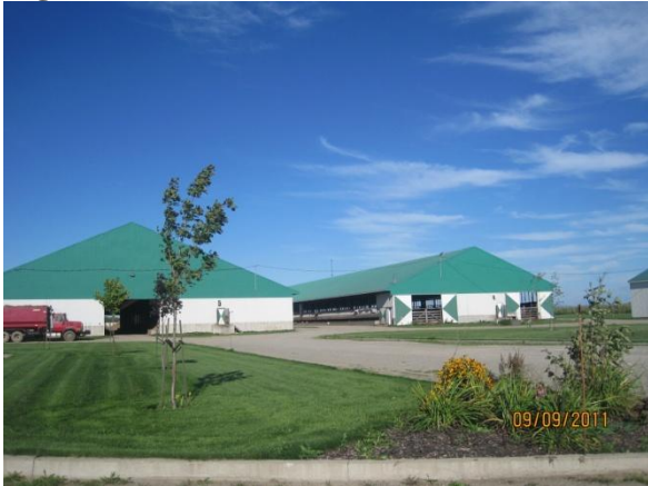
Figure 13 Bâtiments Ferme Jules Côté et Fils inc.
