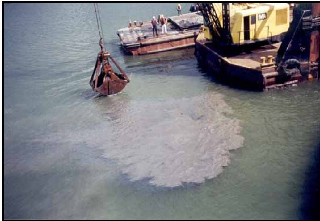
Photo 1 Dragage à benne preneuse en action
