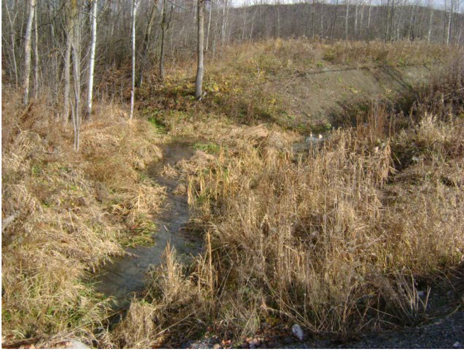
Photographie #3 Vue en amont du chemin Pink du tributaire du ruisseau des Fées (CD1)
