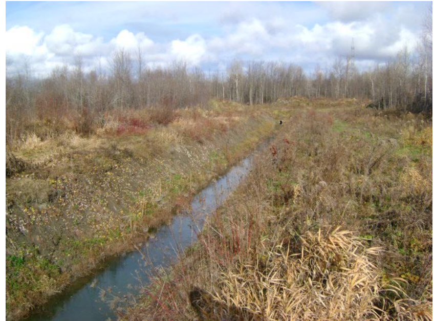
Photographie #12 Aperçu du fossé de drainage au nord du chemin Pink.
