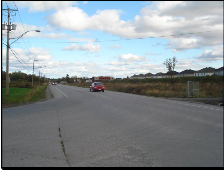
Photographie #9 Chemin Pink en direction est à partir de la rue Vernon Ville de Gatineau, Québec
