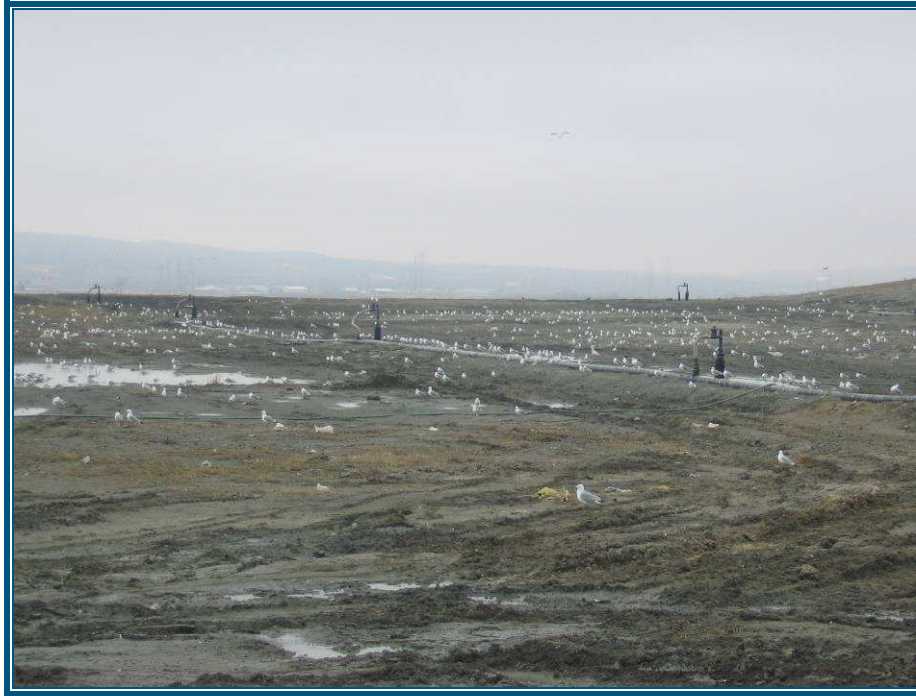
Photo 3 : Puits de captage horizontaux.
