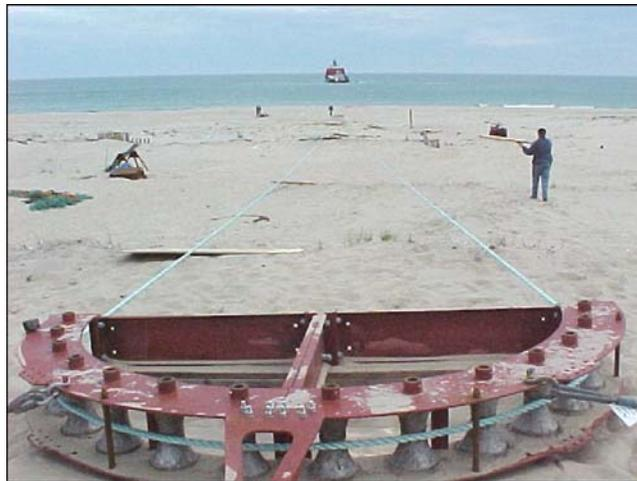
**Figure 4-3: Installation d'une approche à partir du navire avec une poulie sur la rive**
