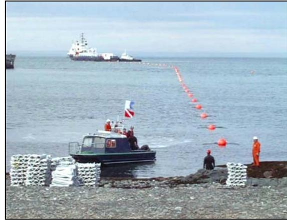
**Figure 4-2: Installation d'une approche à l'aide d'un treuil sur la rive**
