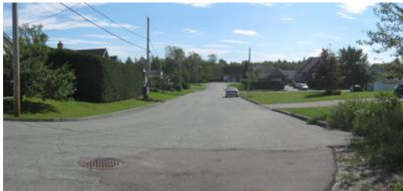
Photo 14 : Tronçon existant de la rue René-Lévesque vue en direction sud (2011-09-09).
