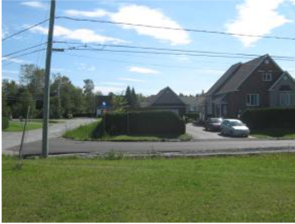
Photo 15 : Bâtiment accessoire situé dans l'emprise projeté du boulevard René-Lévesque. On aperçoit à gauche la rue René-Lévesque actuelle qui devra être élargie dans ce secteur (2011-09-09).
