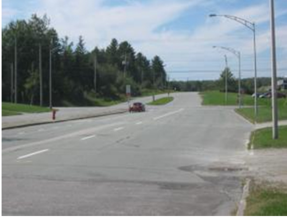
Photo 1 : Intersection du boulevard de Portland avec la rue Pépin. Les voies doubles avec terre-plein central prennent fin peu après l'intersection (2011-09-09).
