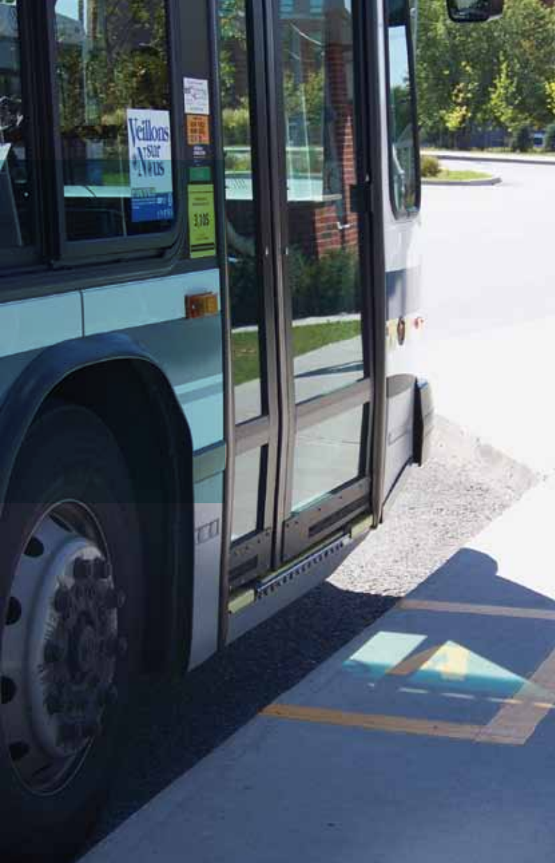
Figure 10 – Hauteur du trottoir insuffisante.
