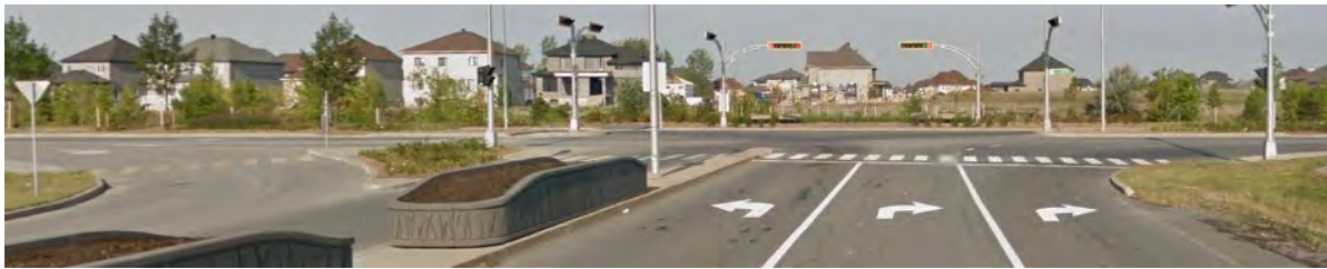
Entrée/sortie de l'A-30 Ouest. Source : Google EarthPro
