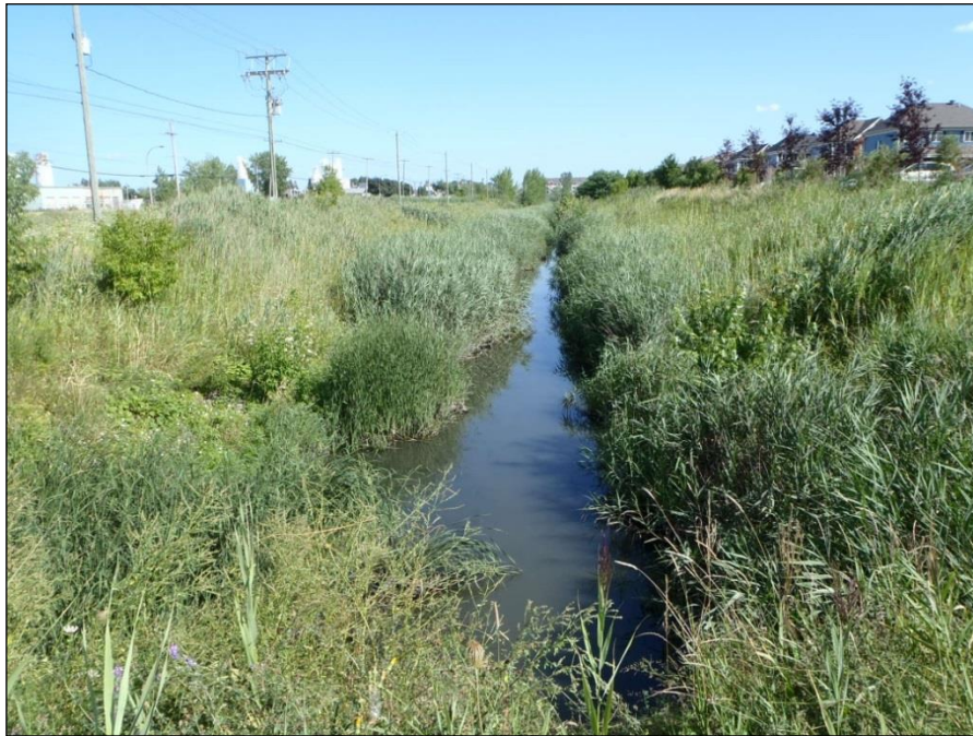
Photographie 2. Vue du secteur aval du ruisseau Daigneault, situé au sud du boulevard de la Grande Allée
