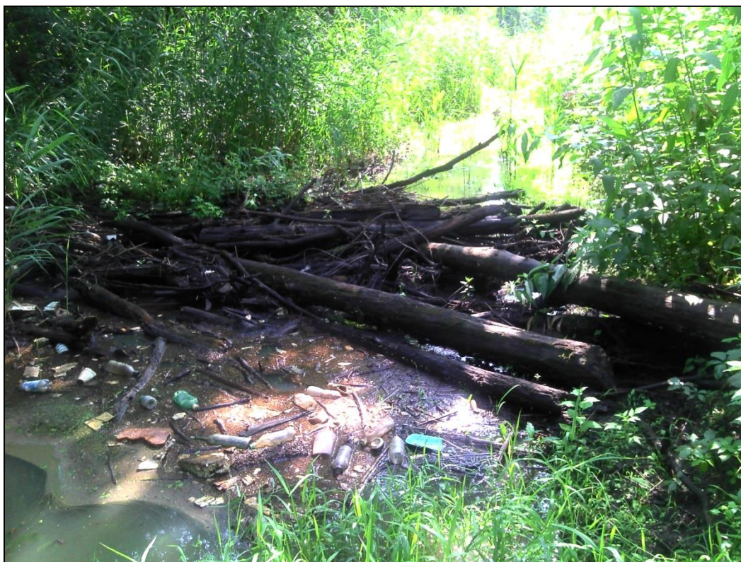
Photo 4 : Exemple d'obstacles à l'écoulement de l'eau
