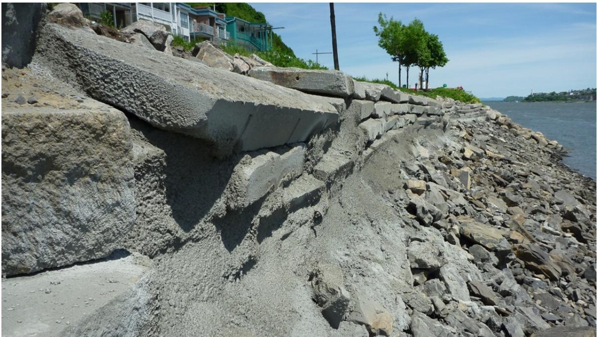
Figure 3.3 Dalles de granit en position précaire – Protection en béton projeté du pied des dalles
