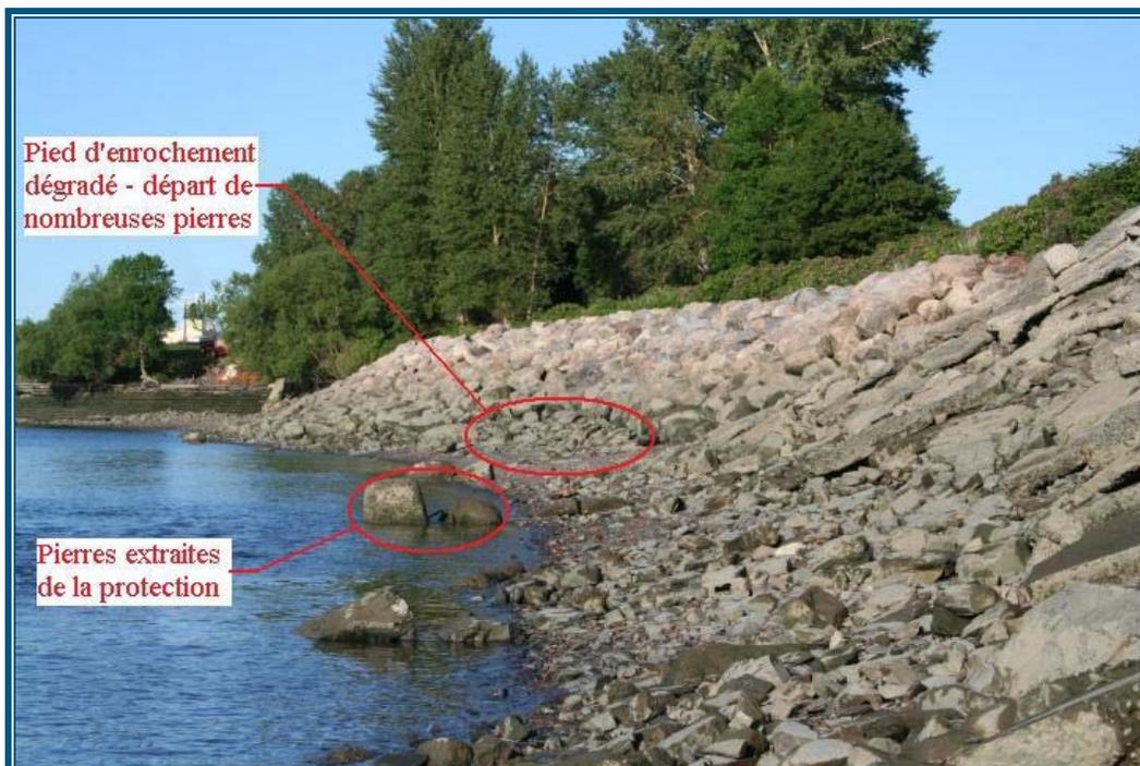
**Photo 4 :** Dégradation du pied de l'enrochement de protection - secteur EB16-EB17 (tiré de CIMA, 2009b).
