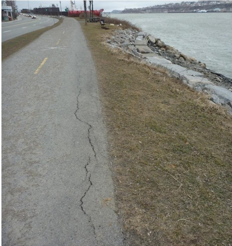
Figure 3.2 Fissures longitudinales dans l'asphalte de la piste cyclable au droit des dalles de granit
