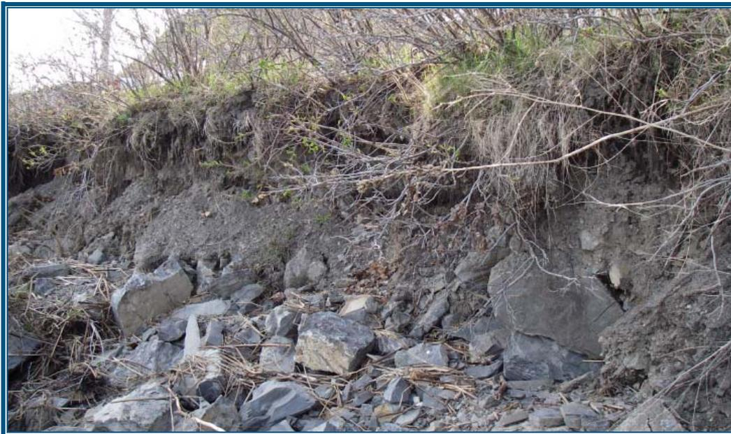
**Photo 2 :** Érosion de la partie supérieure des pentes - secteur EB07-EB10 (tiré de CIMA, 2009b).
